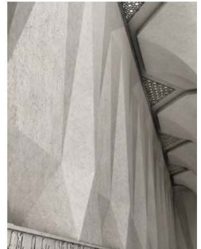
Fig.106 : Mur intérieur de la salle de prière Source : Exposition Batimatec 2018, par ANARGEMA
