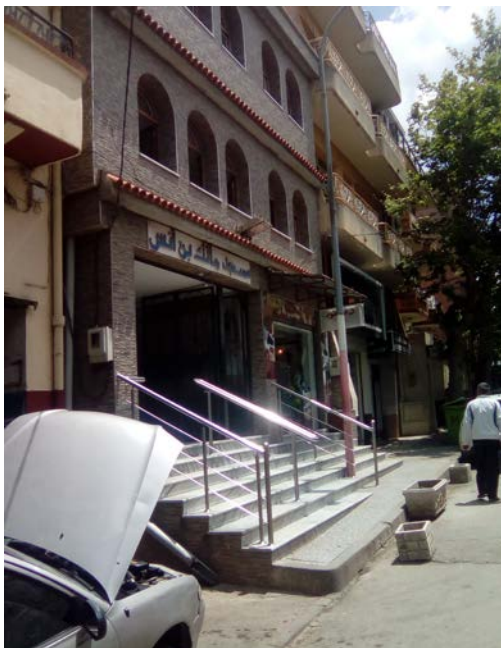
Fig.91 : Empiètement de l'escalier de l'entrée de la mosquée Malek Ibn Anes, sur le trottoir
