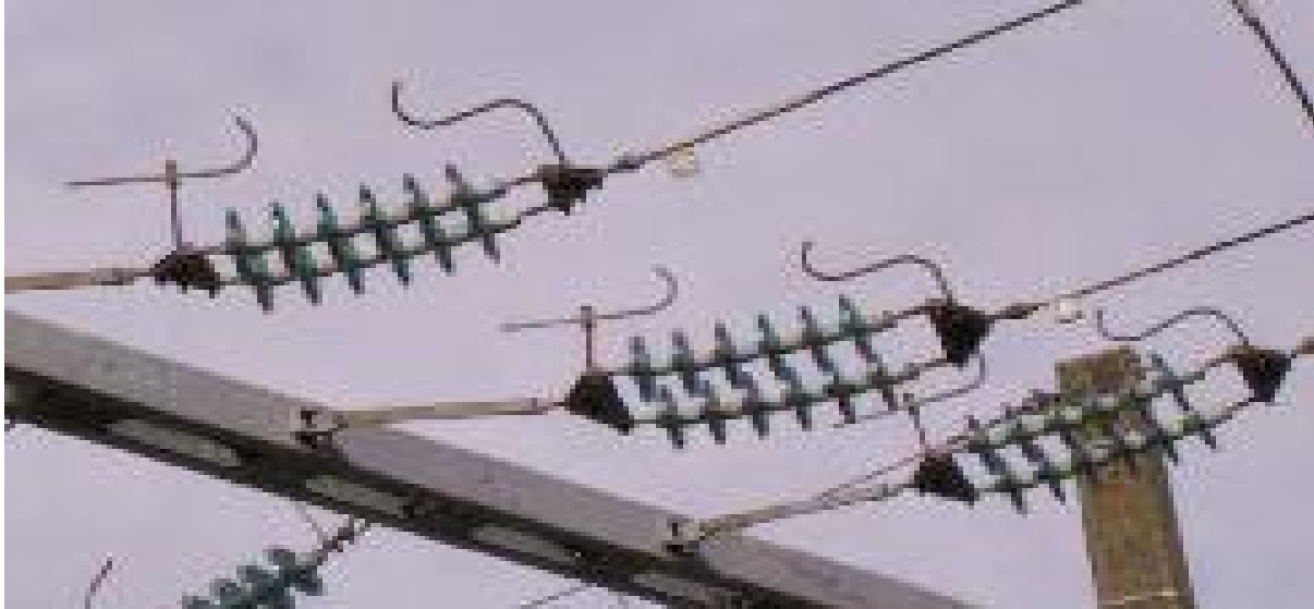
Figure III-16 : éclateur à deux tiges simple [15]
