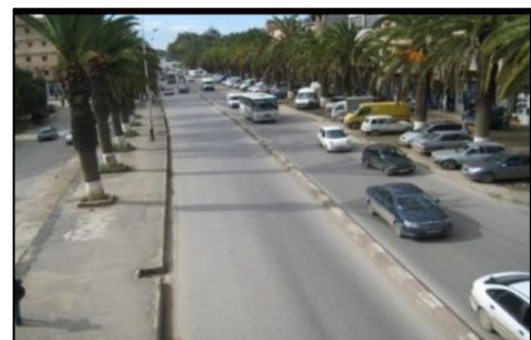
Photo 4: vue sur l'autoroute nationale N24 Source : auteurs.
