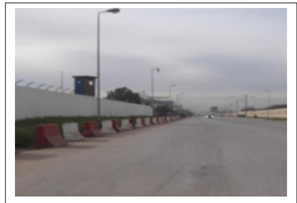
Figure 32 : photo de la zone
