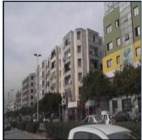
Figure 24: photo de la paroi du côté de la cité 1200log. Source : les auteurs
