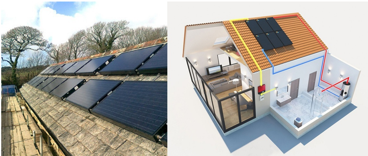
Figure 1: Exemple d'un montage de panneaux PV/T
