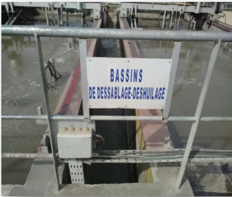
Figure (17) : Dessablage et dégraissage
