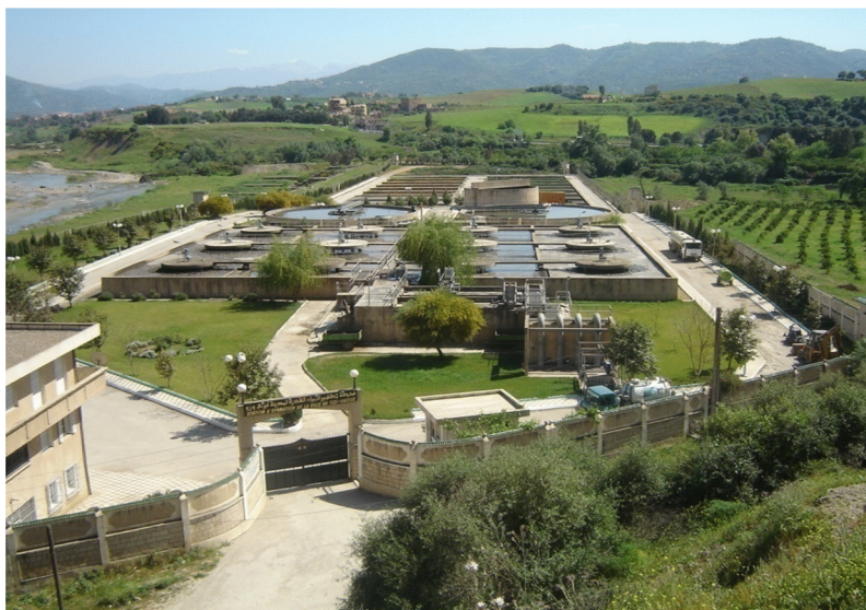
Figure (13) : vue générale de la STEP
