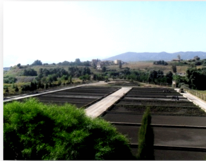
Figure (25) : lit de séchage
