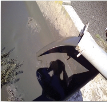
Figure (24) : Remplissage des lits séchés
