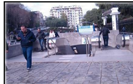
Figure 51: Ligne métro Hamma. Source: Auteurs
