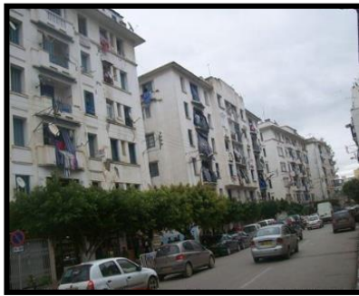
Figure 55: Bâti type HBM en bon état :rue Belouzdad Source: Auteurs.
