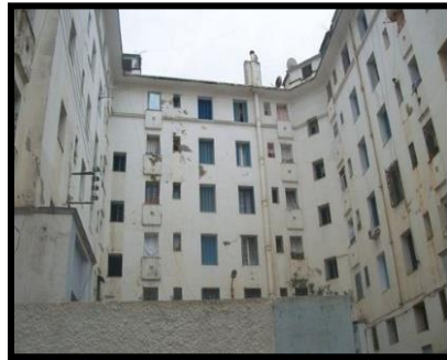
Figure 56: Bâti en bon état (vue du cour) -rue Fernane Source: Auteurs.
