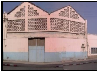
Figure 59: usine en moyen état Source: Auteurs.
