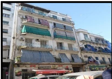
Figure 87 : façade d'un immeuble d'habitation Source : auteur.
