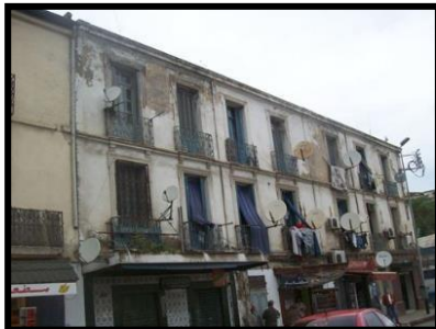
Figure 58: Enveloppe dégradé habitation de type Hlm Source: Auteurs.
