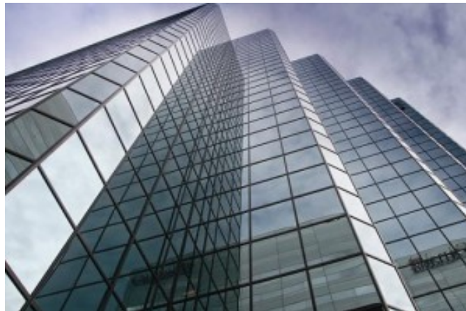
Figure I-5: Application du verre feuilleté dans un building.
