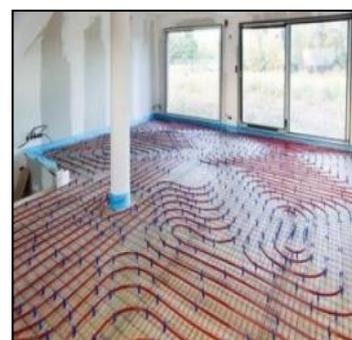
**Figure 68** : plancher chauffant rafraichissant
