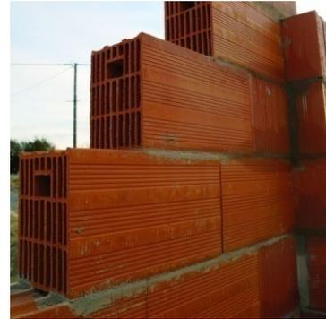
**Figure 141** : cloison en maçonnerie
