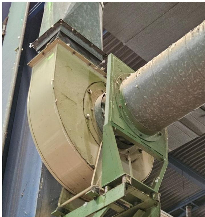
Figure II 9: Le ventilateur radial
