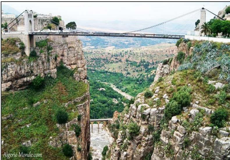
Figure 1-1: Pont Sidi M'Cid de Constantine surplombant les gorges à 175 m de Rhumel ; Année : 1910-1912 ; Longueur : 164 m ; Largeur : 5.75 m
