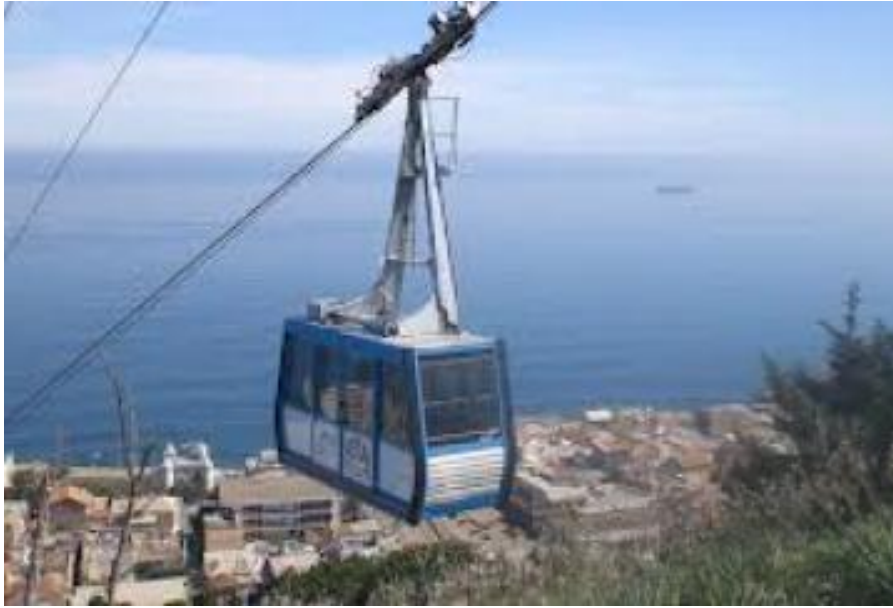
Figure 1-8 : Vue d'une télécabine entre Oued Koriche et Bouzaréah, Alger
