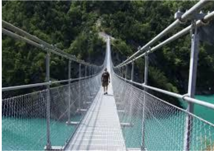
Figure 1-6: Passerelle piétonnière suspendue rigidifiée par des câbles
