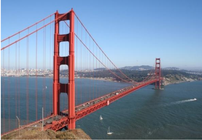
Figure 1-3: Pont du Golden Gate, San-Francisco ; Californie ; Longueur totale : 2737 m ; Portée principale: 1280 m ; Hauteur: 230 m ;
