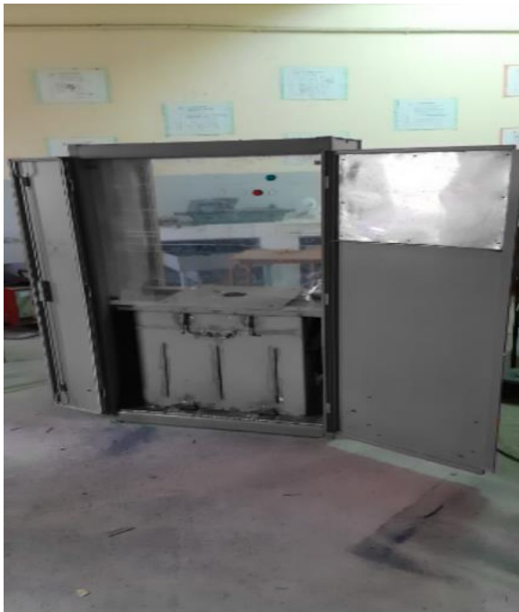
Figure III-29 : La presse à balle avant la peinture
