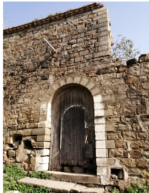
Figure92: la porte d'entré principale de la maison , source :auteur
