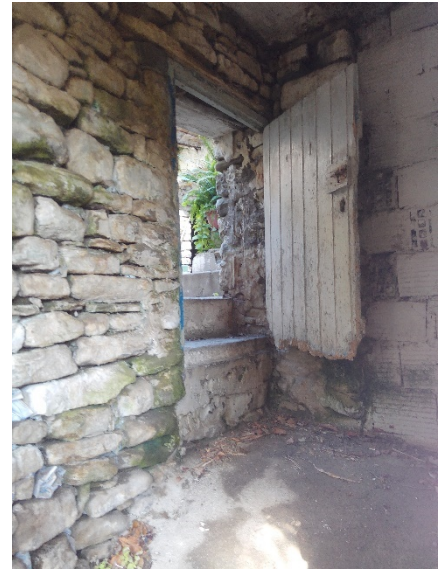
Figure86 :une petite porte qui mène vers le riadh de la maison échantillon , source : l'auteur
