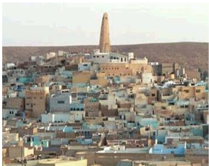
Figure 5: La médina de Ghardaïa construite sur une colline est dominée par le minaret très particulier de la mosquée des Ibadites . Source : ENCARTA, 2009
