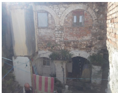
Figure82: vue sur l'intérieur de la maison (sur le patio) source : auteur,2018
