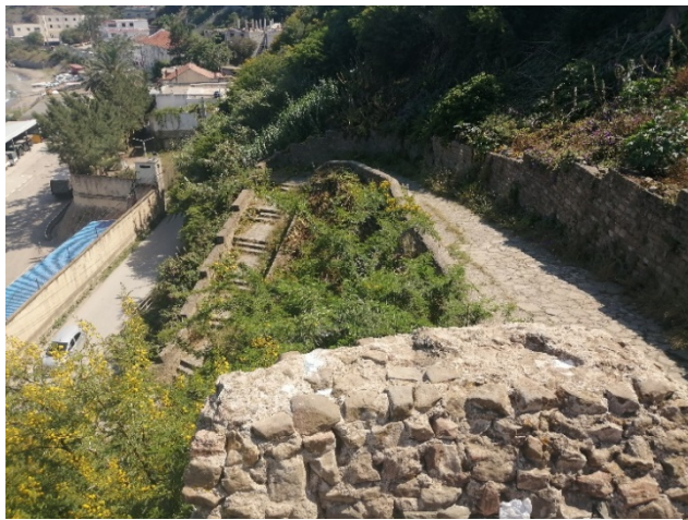
Figure 102 : la rampe qui relie la casbah du port . source : auteur
