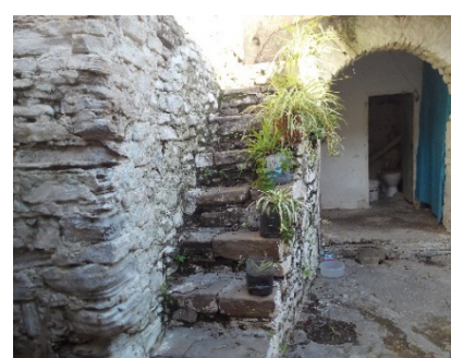
Figure84: vue sur l'intérieur de la maison (sur le patio) source : auteur,2018
