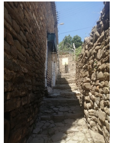
Figure 90 : escalier qui relie el mizab avec le petit jardin de la casbah .source :l'auteur
