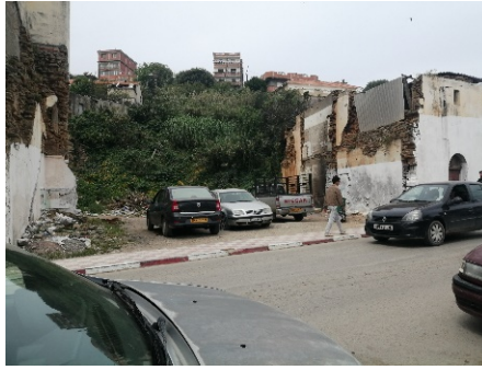
Figure46 : photos sur la façade haute casbah de la RN24 . source : auteur .
