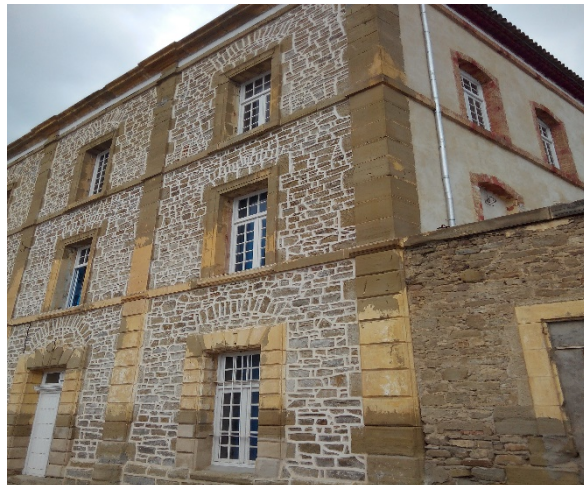
Figure28: L'ex Bâtiment Du Génie Militaire source : prise par l'auteur
