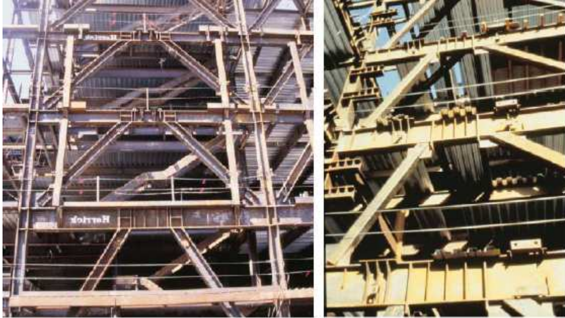
Figure II.16 Raidissage du tronçon d'excentrement court en cours de construction.
