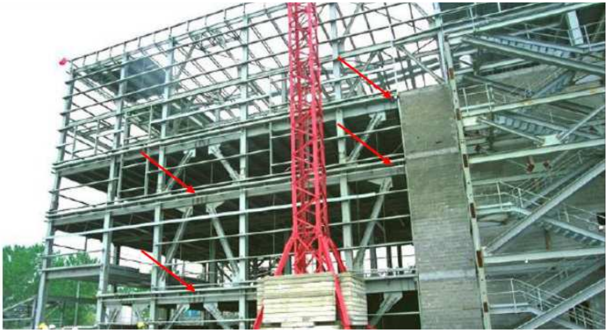
Figure II.11 .Bâtiment avec triangulation excentrée aux USA [19]
