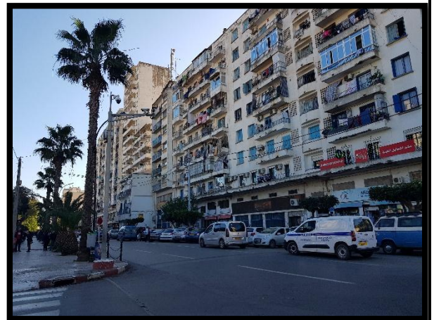
Figure 76 : Rue Mohamed Belouizdad.
