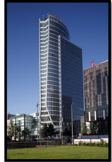
Figure 134 : La tour oxygène, Lyon, France.
