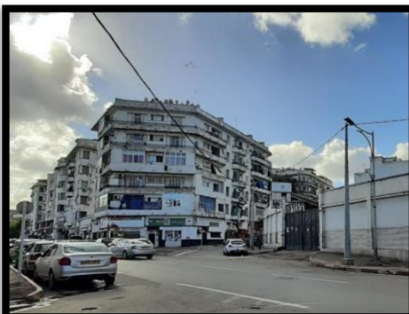
Figure 60 : Immeuble d'habitation HLM et HBM. Source : Auteurs.
