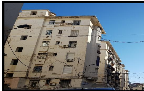
Figure 57 : Bâti à moyenne hauteur.
