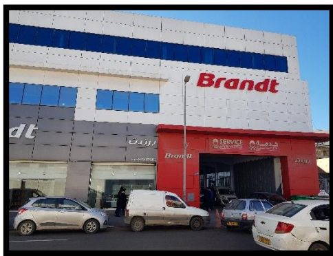
Figure 127 : Siège Brandt. Source : Auteurs.
