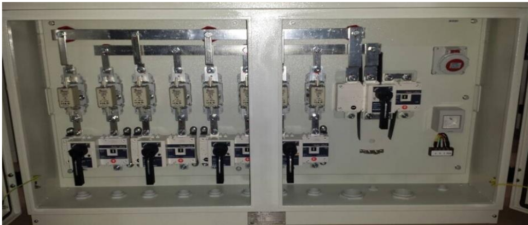
Figure I.4 : Configuration de la boîte jonction Parallèle.
