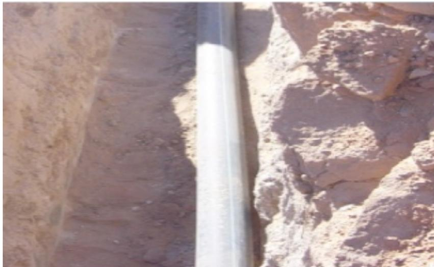
**Figure5.1 : Pose des conduites en terre**
