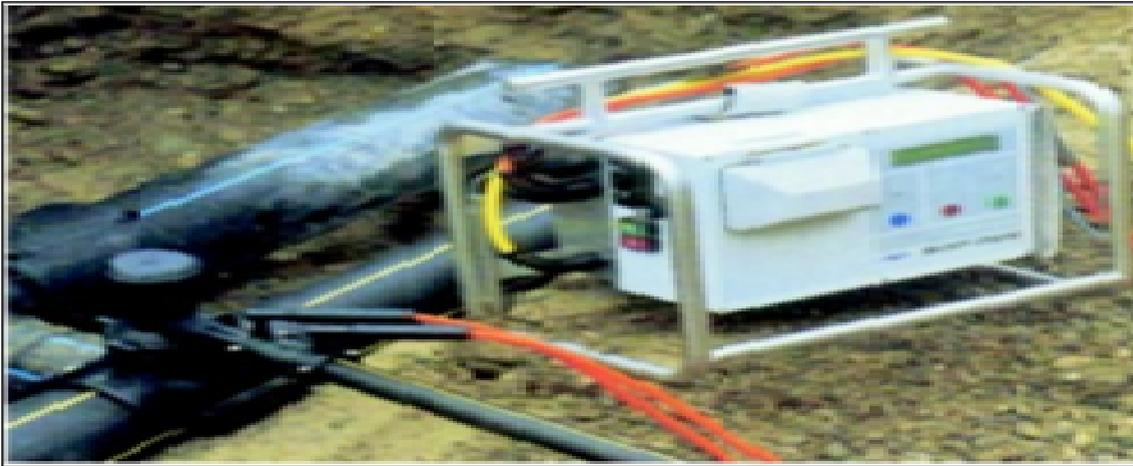
**Figure 6.4: Assemblage par électro-soudage**
