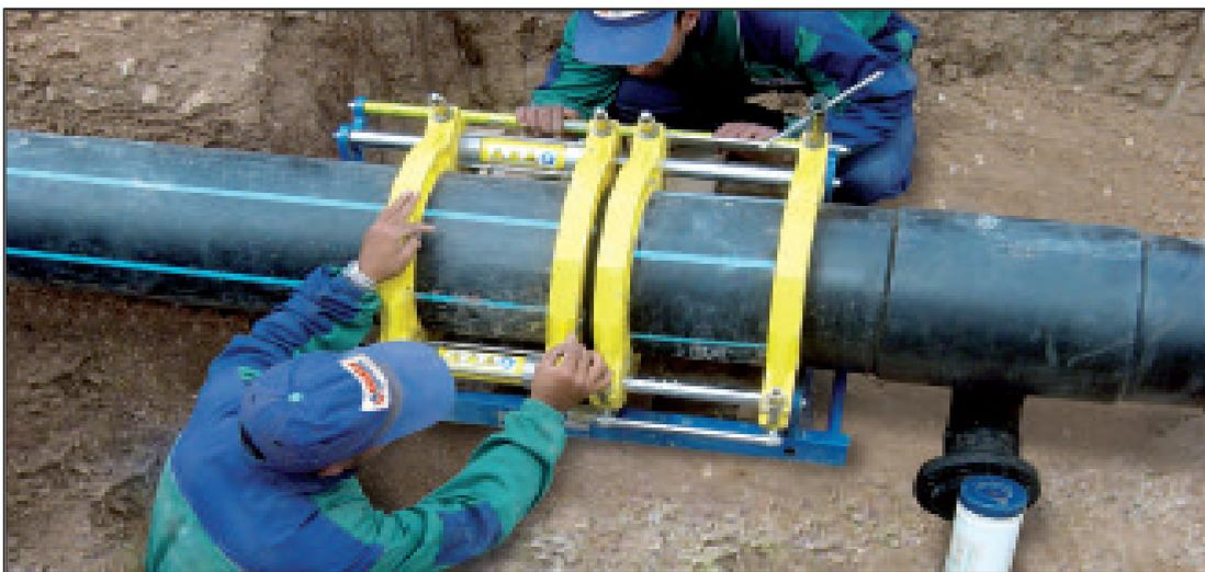
**Figure 6.3 : Le soudage de bout à bout des tubes en polyéthylène (PEHD)**
