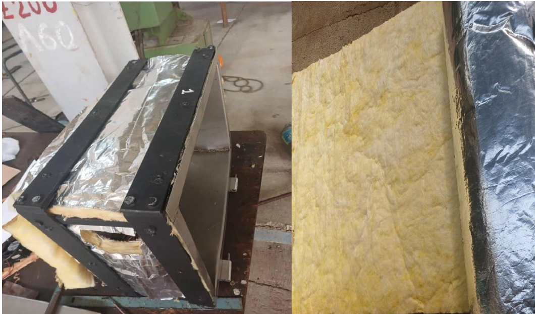
Figure III.15 : La laine de verre mise autour de l'enceinte.
