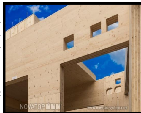
Figure108 : Structure en bois
