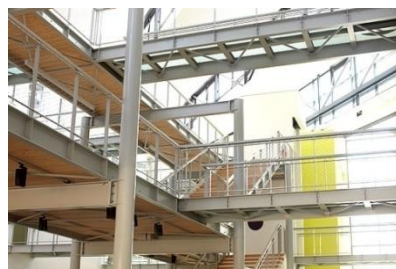
Figure121 : Structure avec poteaux en aluminium Source : pv-element-structurant-architecture.pdf
