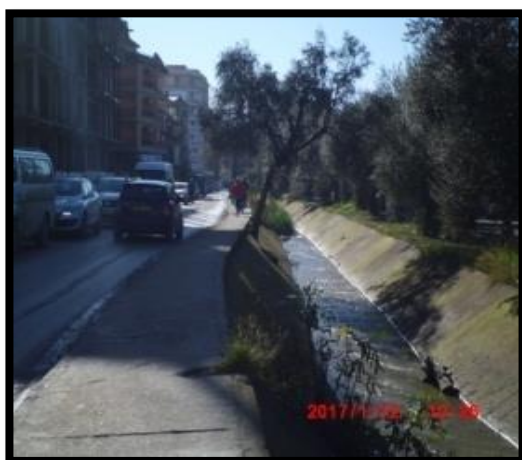
Figure 38 : Rue d'oued Ouesgouili Source : Photo prise auteurs le 12/01/2017
