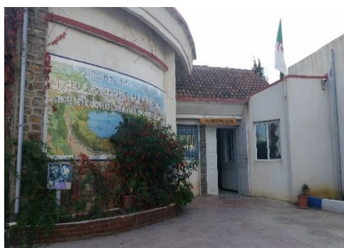
Figure144: La façade principale du centre d'éducation environnemental du PNG
