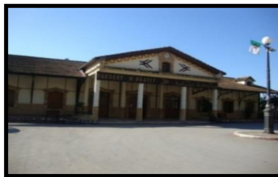
Figure15 : La gare ferroviaire
