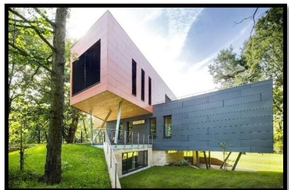
Figure 99 : Façade latérale Source : www.paleta.cz
