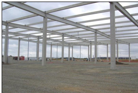
Figure239 : structure poteaux poutre Source : http://beton-prefabrique.fr/IMG/jpg/elements-structure-15.jpg
