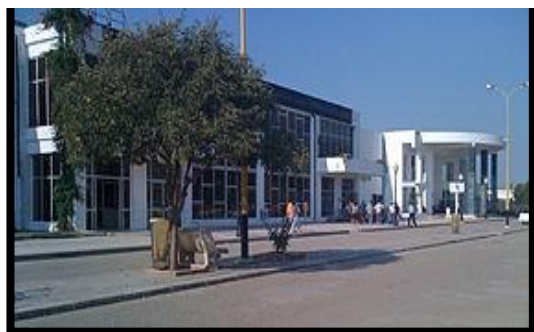
Figure 14 : L'aéroport ABBANE REMDANE
