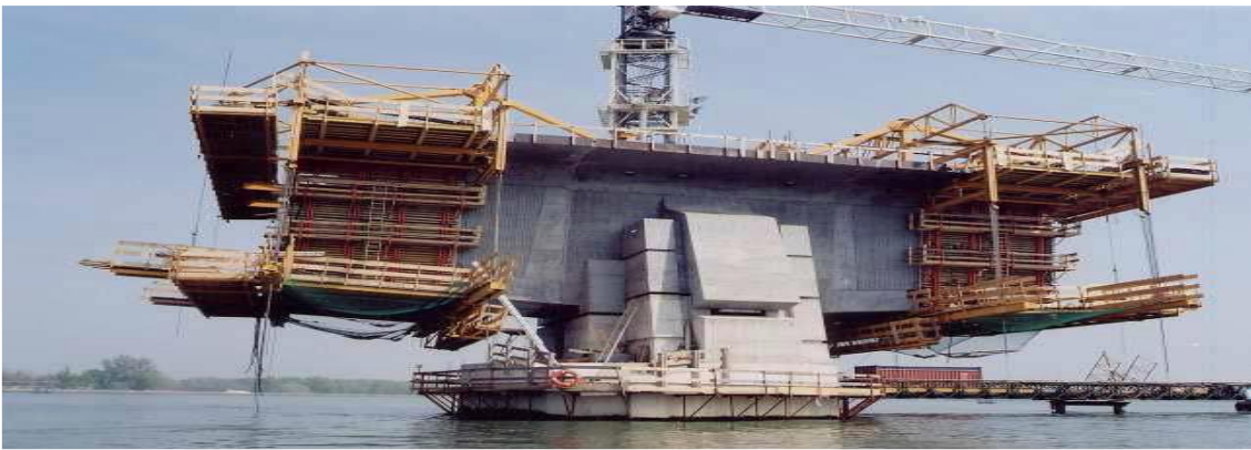
Fig. I.9 : voussoirs coulés sur place
