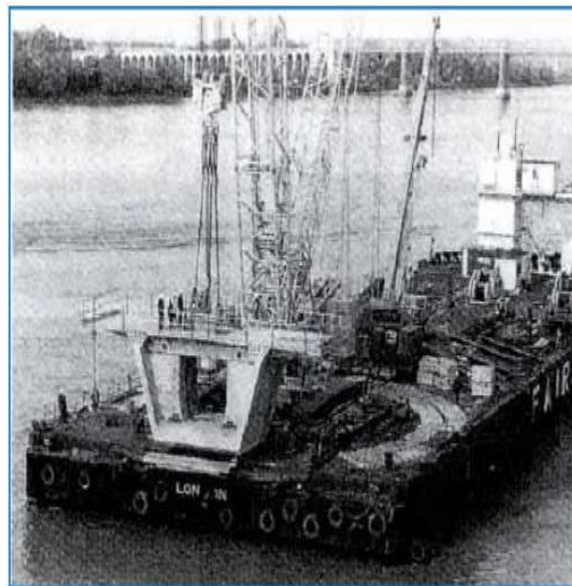
Fig. I.16 : Pose à la grue fluviale
