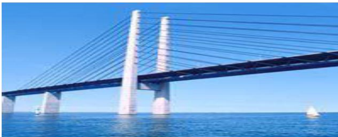
Fig. I.19 : Pont à haubans.
