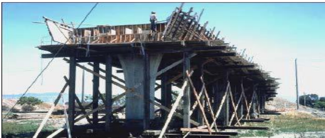
Fig. I.7 : Tablier coulé sur cintre
