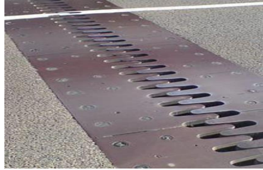
Fig.IX.2. Joint du type Wd (souffle moyen)
