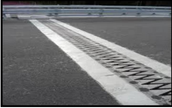
Fig.IX.2. Joint du type Wd (souffle moyen)
