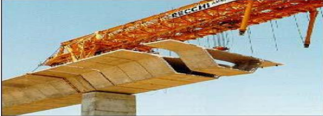
Fig. I.11 : Pose des voussoirs préfabriqués.
