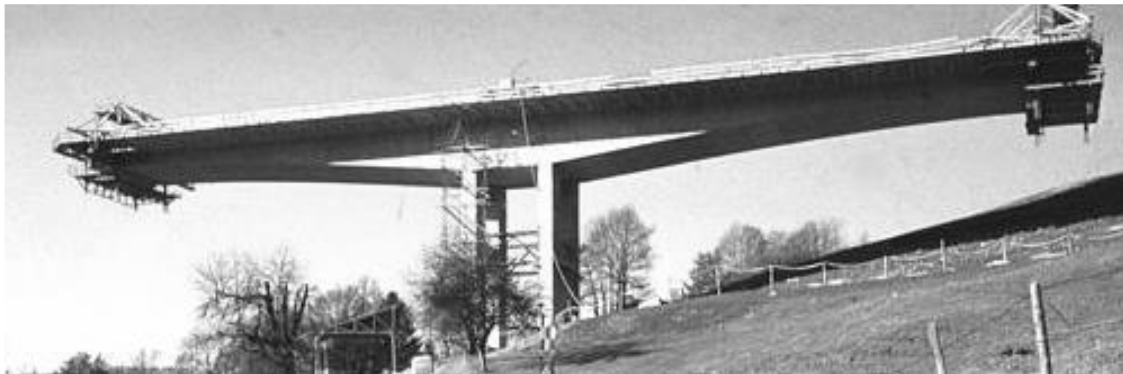
Fig. I.10 : Stabilité du fléau lors de la réalisation.
