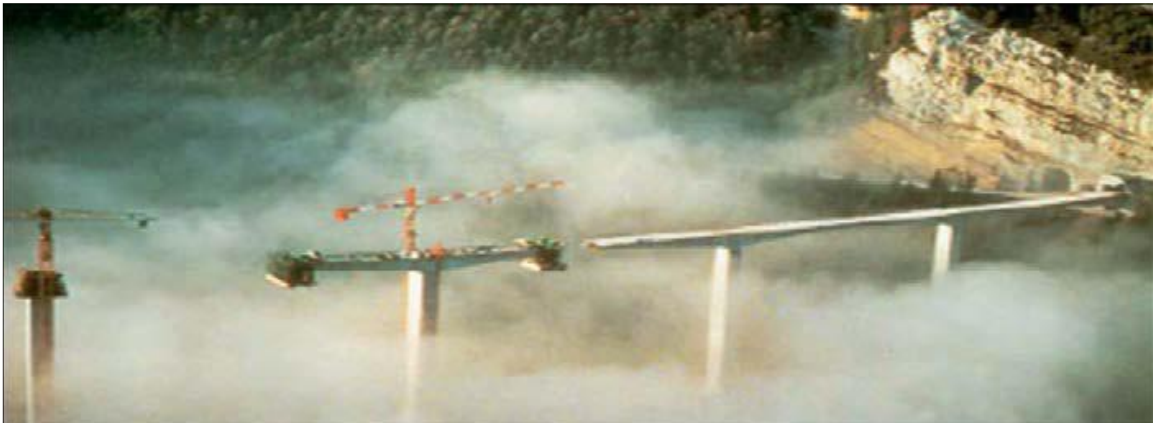
Fig. I.8 : Construction par encorbellement
