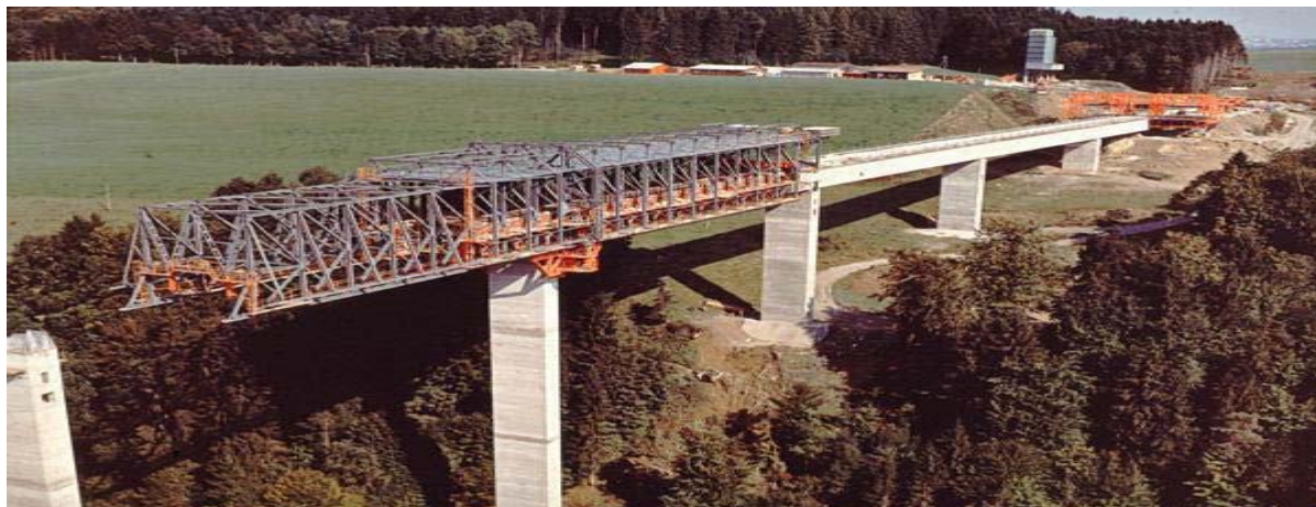
Fig. I.6 : Construction par poussage
