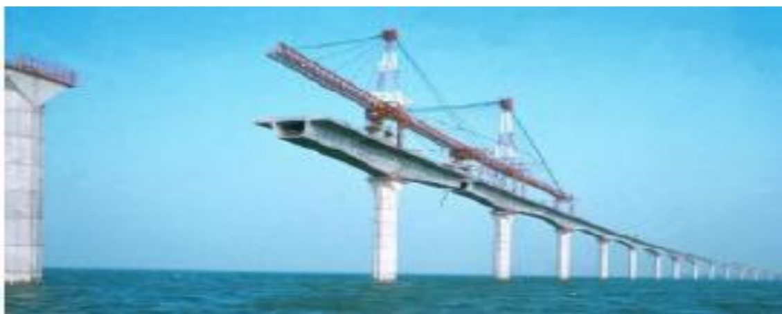
Fig. I.14 : Poutres de lancement des voussoirs.
