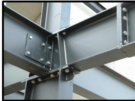
Figure 89: assemblage rigide des poutres boulonnées
