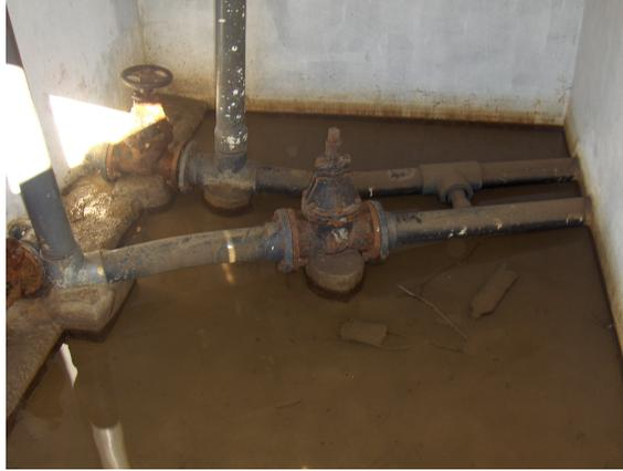
**Figure 8 :** *Corrosion de la robinetterie du réservoir Mezoui [Photo Hammoum].*
