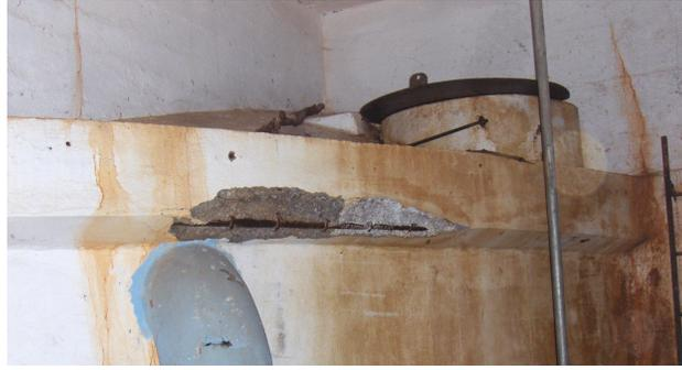
**Figure 5 :** Aciers dénudés sur la ceinture supérieure du réservoir La crête [Photo Hammoum].
