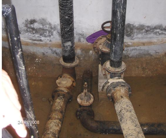
**Figure 15** : Efflorescence au réservoir Harrathen [Photo Hammoum].
