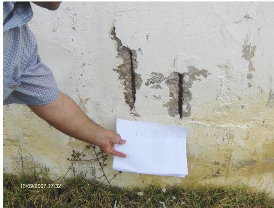
**Figure 17 :** Absence d'enrobage des aciers verticaux du réservoir Ouled Aissa [Photo Hammoum].
