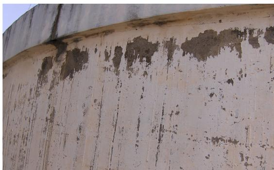
**Figure 11 :** Ecaillage sous la ceinture supérieure du réservoir Tassoust [Photo Hammoum].
