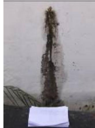
Figure 53. Fuite sur la paroi du réservoir
