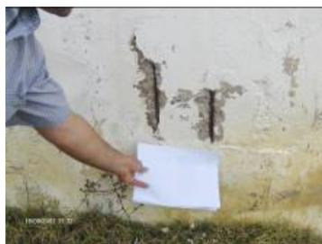
**Figure 49.** Corrosion des aciers
