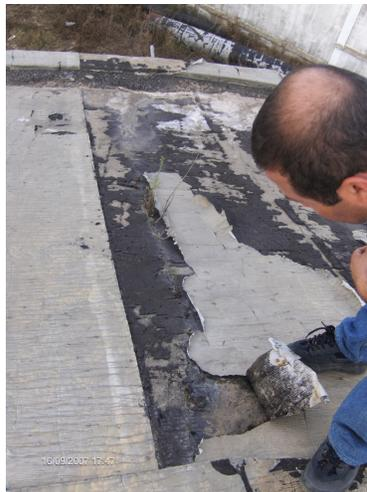
**Figure 6 :** Complexe d'étanchéité de la coupole dégradé du réservoir Ouled Aissa [Photo Hammoum].
