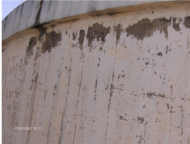
Figure 60 : Dégradation des peintures et enduits en ambiance marine [Photo Hammoum]
