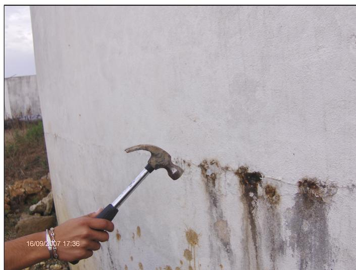
**Figure 42.** Fissure horizontale au niveau de la bande du fond de la paroi [Photo Hammoum].
