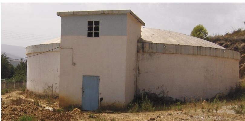
**Figure 3 :** *Réservoir circulaire posé au sol en béton armé [photo Hammoum].*
