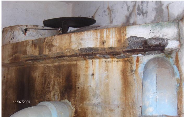
**Figure 7 :** Corrosion des aciers du réservoir La crête [Photo Hammoum].
