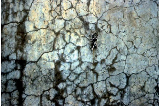
**Figure 58** : maillage de fissures sur la paroi intérieure d'un réservoir (Godart)
