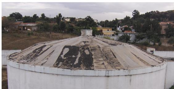
**Figure 10 :** Déformation de la coupole du réservoir Ouled Aissa [Photo Hammoum].
