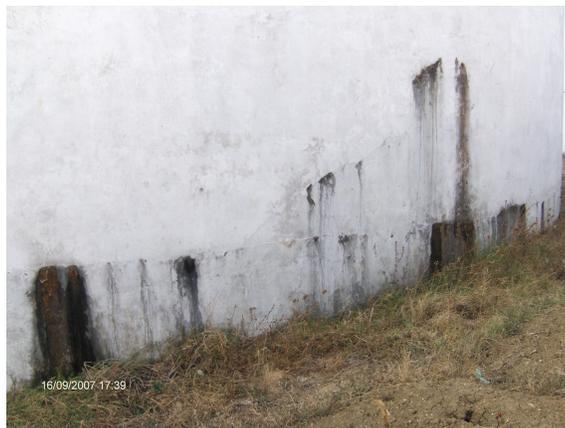
**Figure 16** : Fissures horizontales et obliques au réservoir Ouled Aissa [Photo Hammoum].
