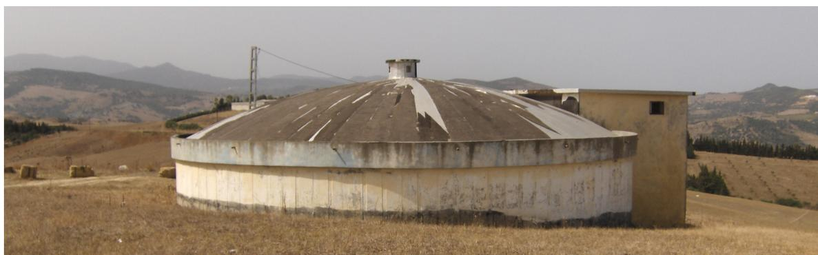
**Figure 2 :** *Réservoir circulaire semi enterré en béton armé [photo Hammoum].*
