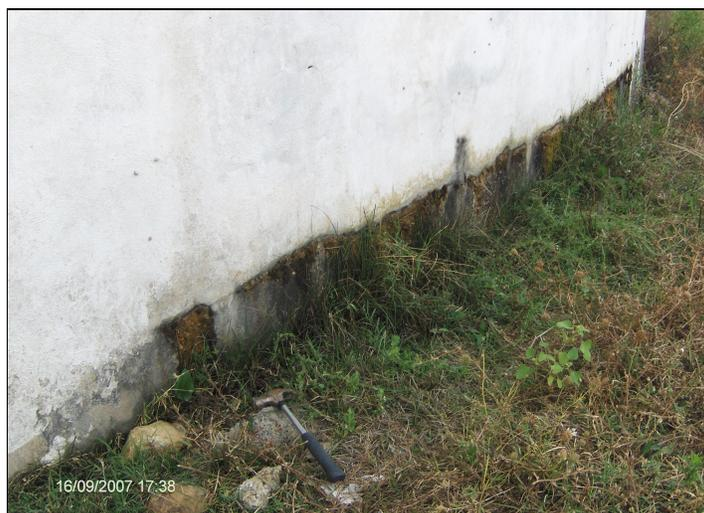
**Figure 41.** Fissure horizontale à la base de la paroi [Photo Hammoum].
