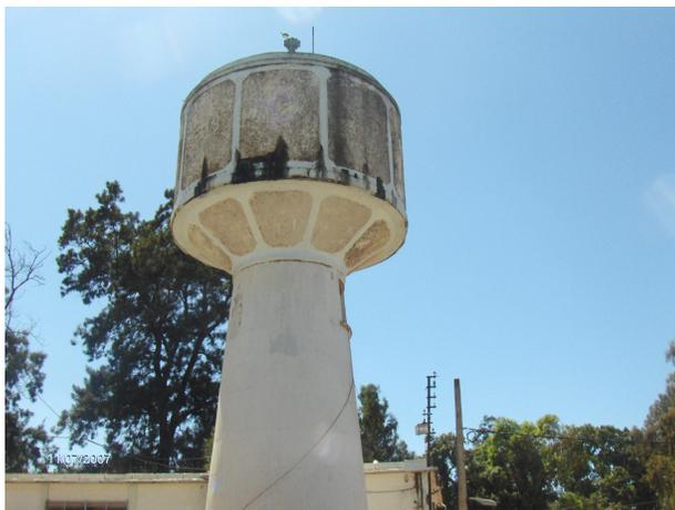
**Figure 1 :** *Réservoir surélevé sur tour en béton armé [photo Hammoum].*
