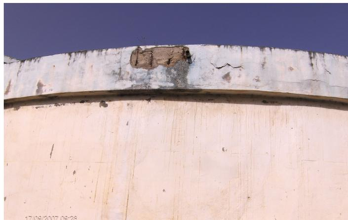
**Figure 18 :** Gonflement au niveau de la ceinture supérieure du réservoir Tassoust [Photo Hammoum].
