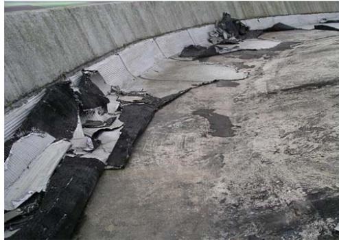
Figure 62 : Dégradation du complexe d'étanchéité sur coupole [photo Hammoum].
