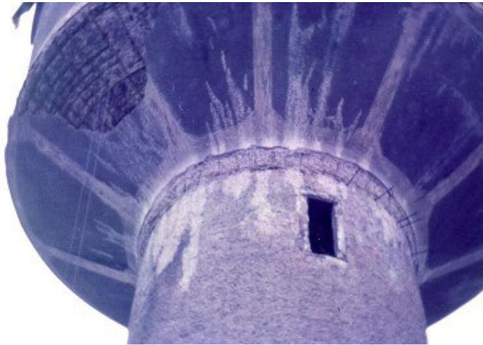
**Figure 59** : Corrosion des aciers du tronc de cône
