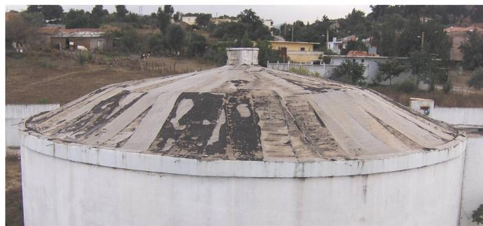
**Figure 51.** Complexe d'étanchéité de la coupole du réservoir détérioré
