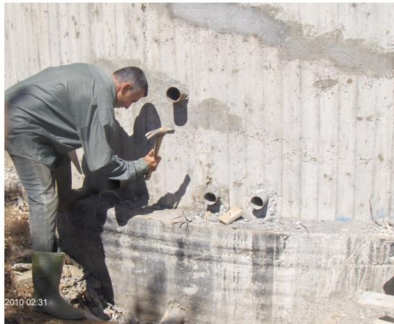
**Figure 12 :** Traitement des ségrégations du béton sur paroi du réservoir Ait Bouyahia [Photo Hammoum].
