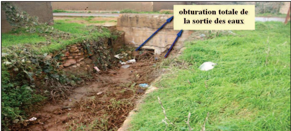
**Figure II.8 : Canal obstrué sous l'effet des déchets emportés par les eaux de pluies (photo AGC).**
