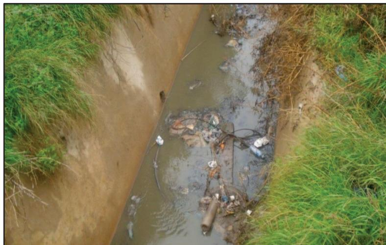
**Figure II.9 : Obstruction des canaux par des ordures ménagères (photo AGC)**
