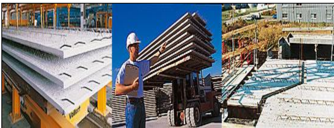
Figure I.8 : Dalle à poutrelles.
