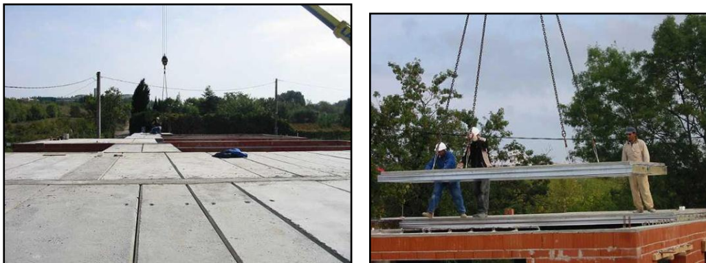
Figure I.2 : Exécution d'une dalle.
