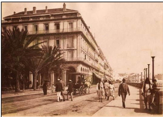
Figure 7 : bâti colonial Alger Source : www.tsa-algerie.com/
