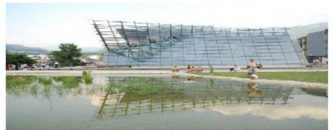
Figure 83 : Vue du projet dans son site Source : http://www.floornature.eu/
