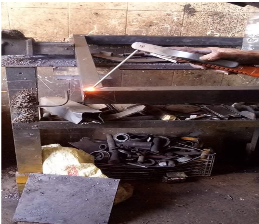
Figure III.24 : Soudage à l'arc électrique « photo prise dans l'atelier »
