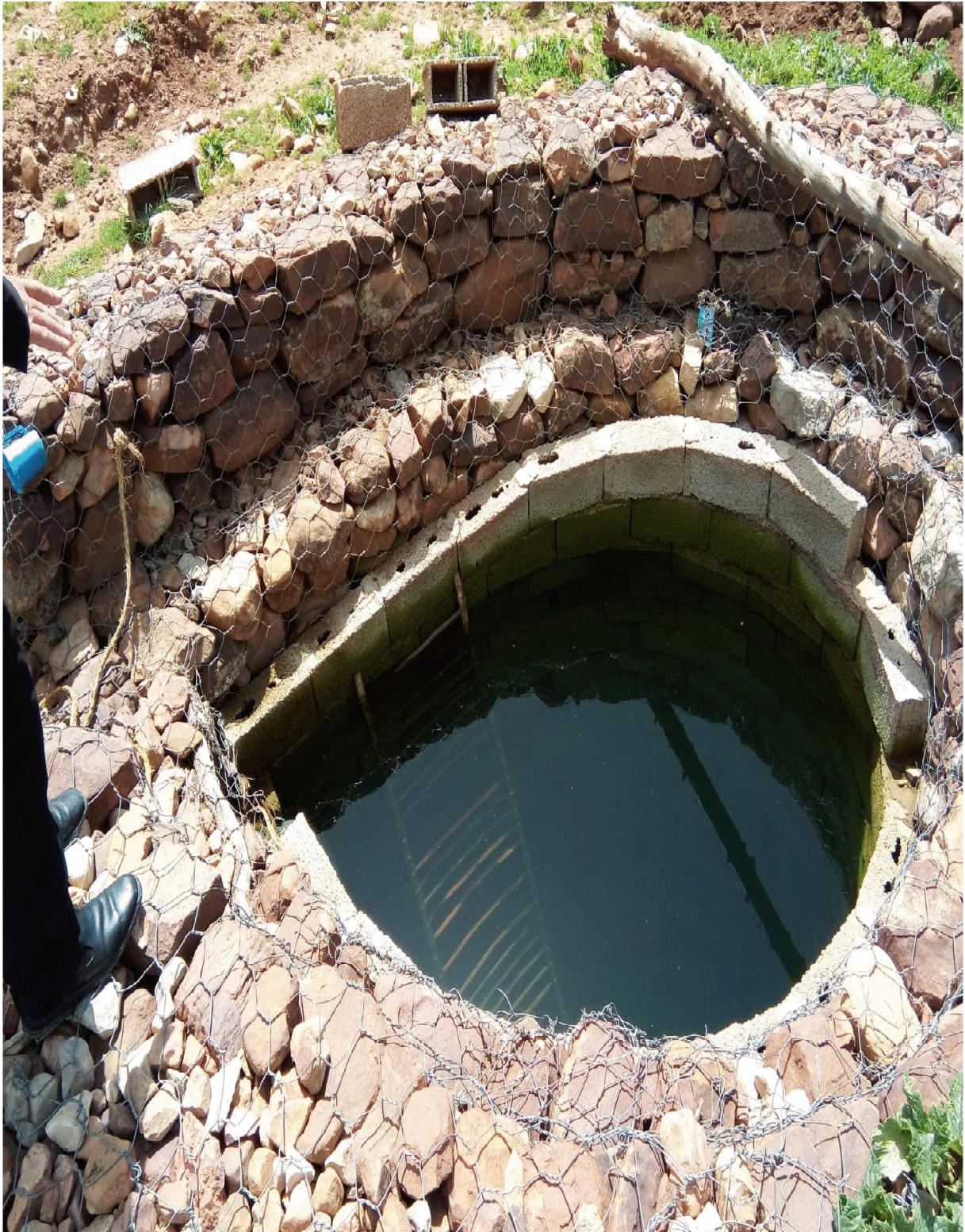
Point d'eau de ravitaillement de weldlakhdar (prise personnelle)
