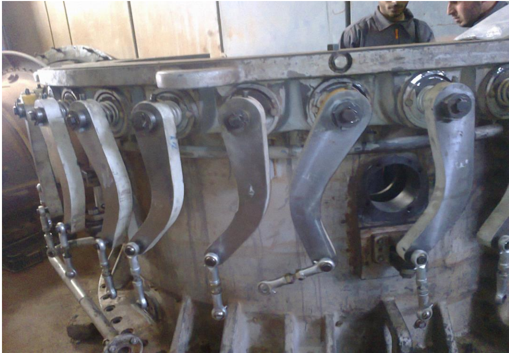
Fig.21 : ensemble directrice 2eme étage photo prise par moi-même sur le site.
