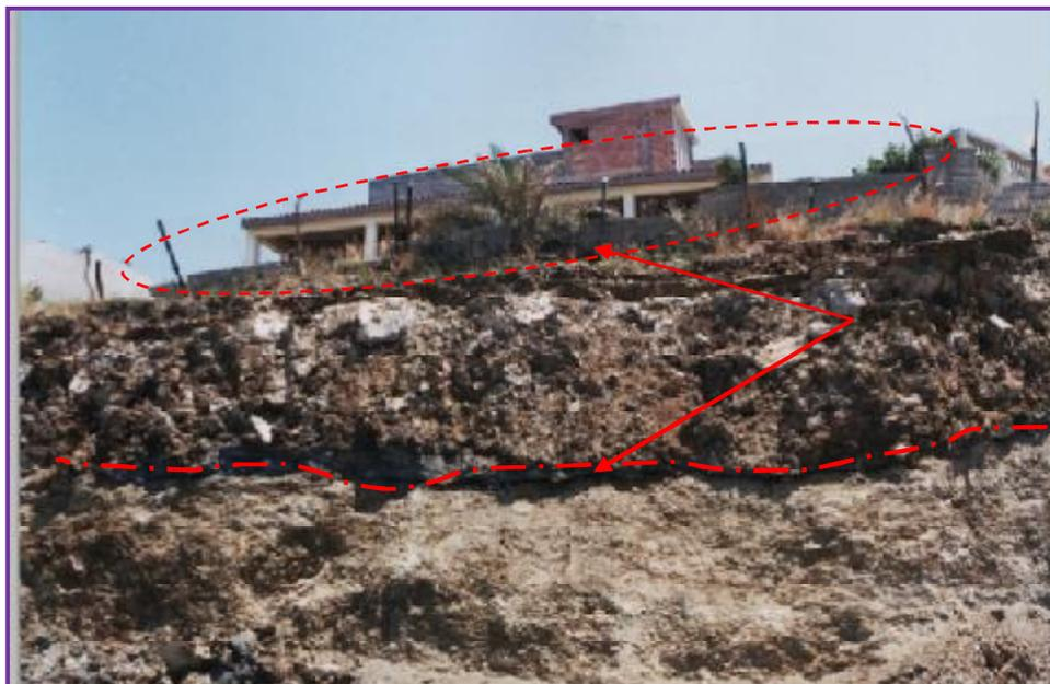
Figure I- 23 : Effondrement du mur de clôture de la maison par translation de la fondation selon cette ligne de rupture.
