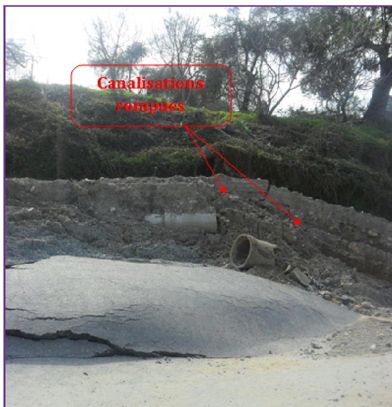
Figure. II. 3: Exemples de canalisations rompues lors d'un glissement de terrain
