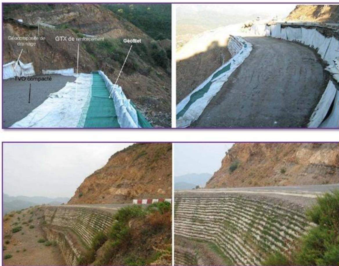
**Figure. II. 24 : Les différentes phases des travaux de renforcement par géotextiles**
