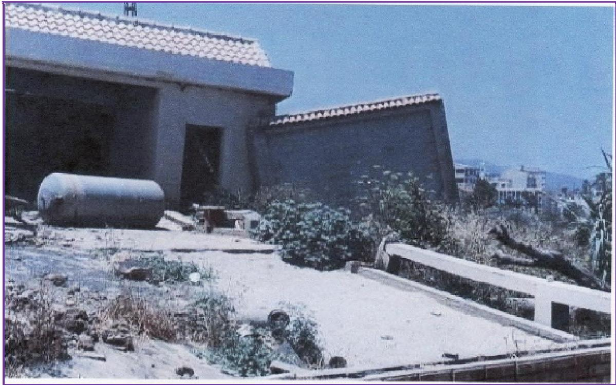
**Figure I- 17 : Montrant l'affaissement et l'inclinaison d'un mur en maçonnerie chaînée.**
