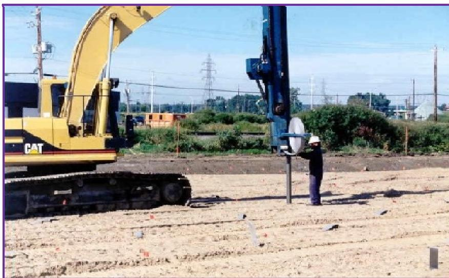
Figure. II. 14 : Installation des drains verticaux (Document Géopac)
