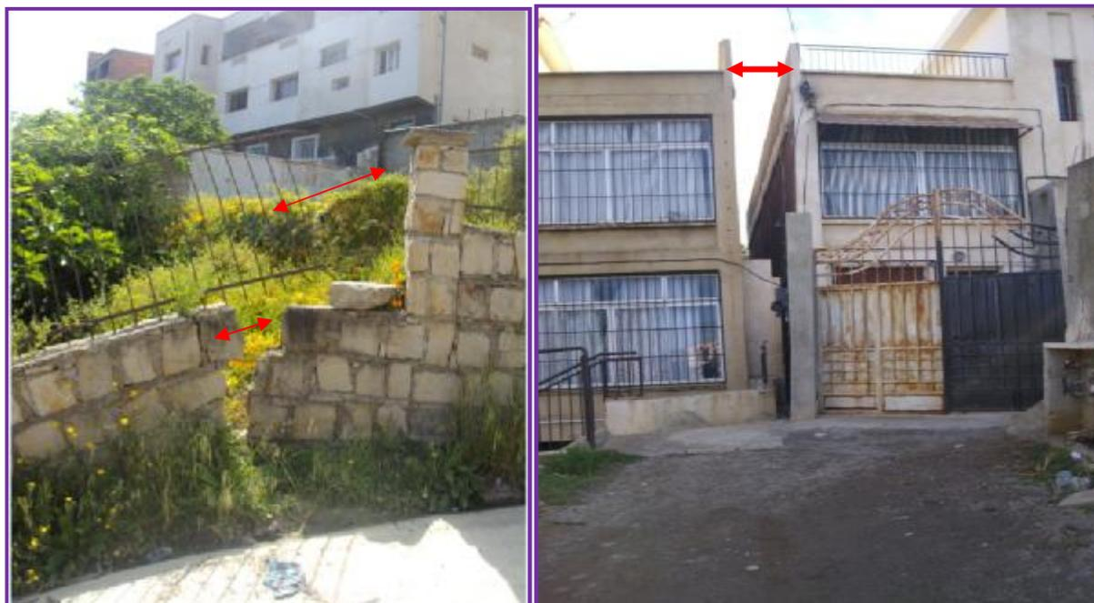
**Figure I- 25 : Fissures dans les murs de clôtures en pierres et ouverture d'un joint entre deux blocs**
