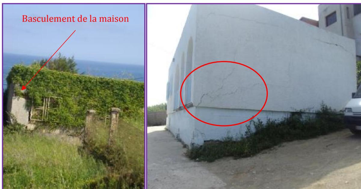
**Figure I- 26 : Basculement du bungalow à gauche évacué et endommagement de cette clinique toujours en usage à droite.**
