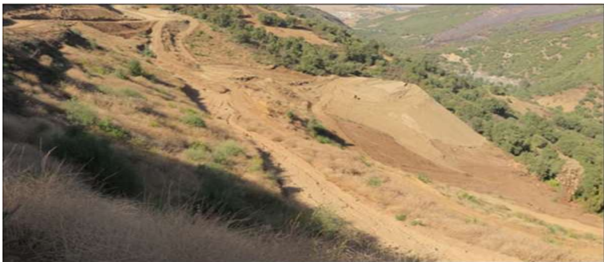
Figure 4. 3:Vue des zones de déblais remblais entre pk 16+309 –pk16+500
