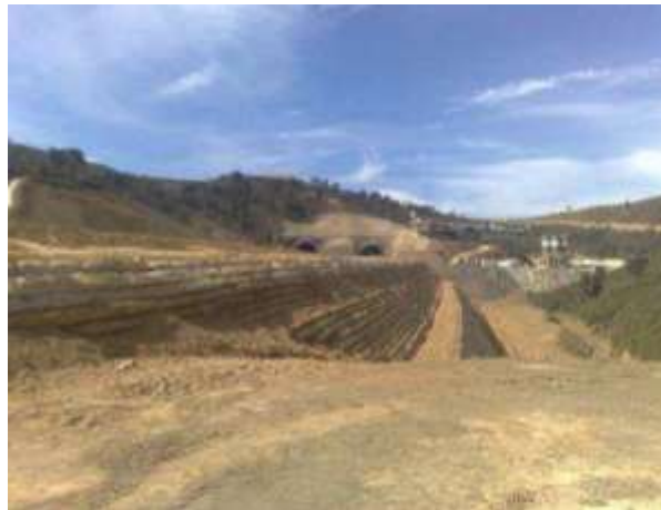
Figure 1. 5: Ouvrage en remblai renforcé PK22+400 pénétrante Tizi Ouzou
