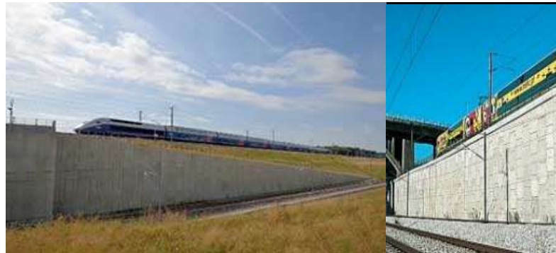
Figure 1. 13:Utilisation de la terre armé
