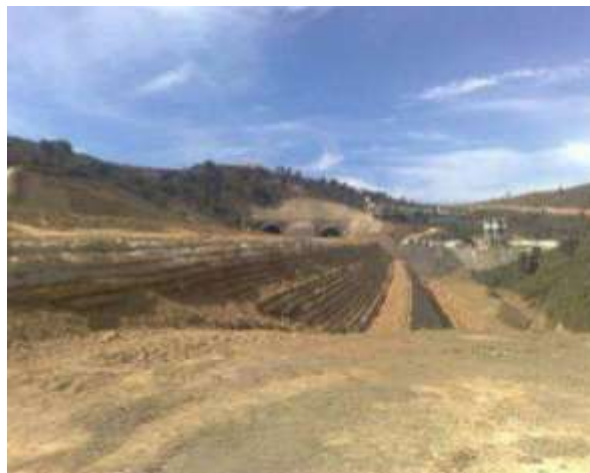
Figure 5. 11:Mur de terre armée
