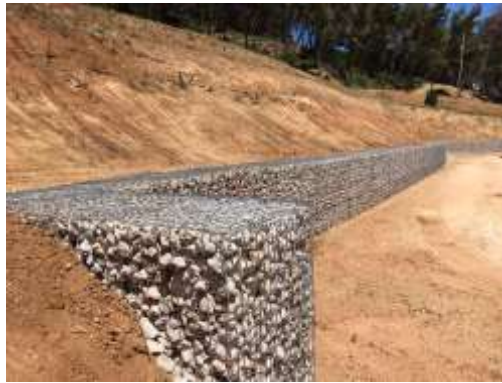
Figure 1. 3:Exemple d'un gabion
