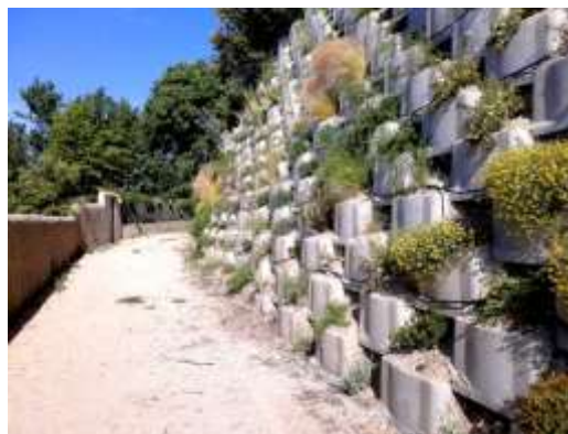
Figure 1. 4:Exemple de chantier en caissons Rboul
