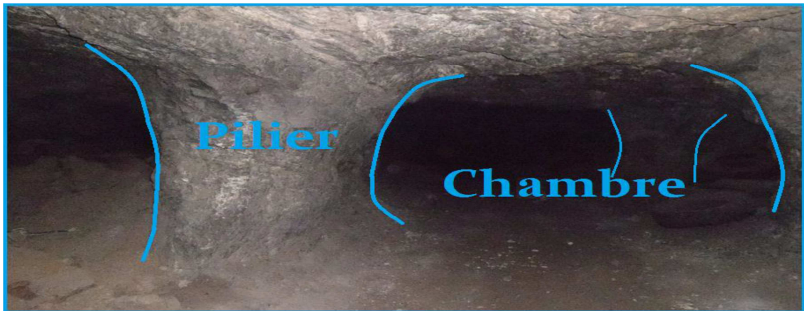
Fig 30: Photo d'une chambre et d'un pilier abandonné à El Abed .(BOUDIAF.M)
