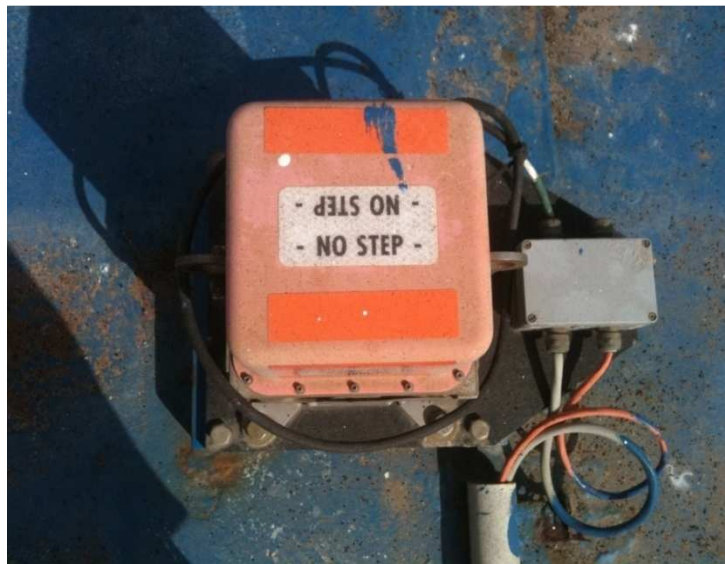
Figure III.14 : câbles d'alimentation et d'Ethernet.
