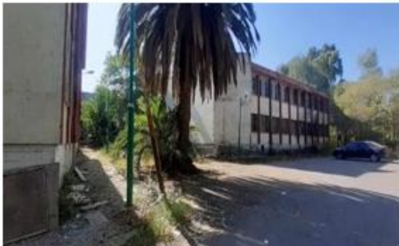
Figure 32 vue sur la façade du bloc B
