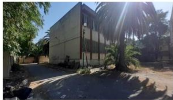
Figure 33 vue sur la façade du bloc A
