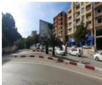
Figure 53 vues sur nœud Chabane Ahcene
