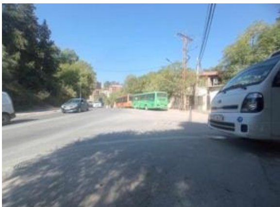
Figure 36 CW 100 avant l'intervention source auteurs
