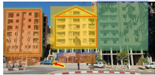
Figure 62 vue sur une partie de façade urbaine donnant sur Chabane Ahcene Source auteurs
