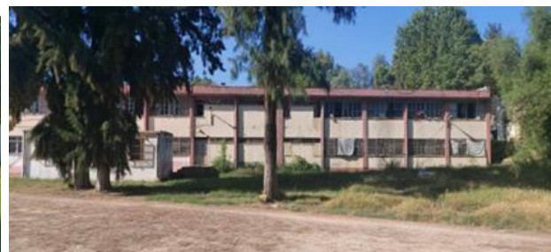
Figure 31 vue sur le pavillon A
