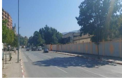
Figure 40 vue sur la clôture cotée avenue CHABANE
