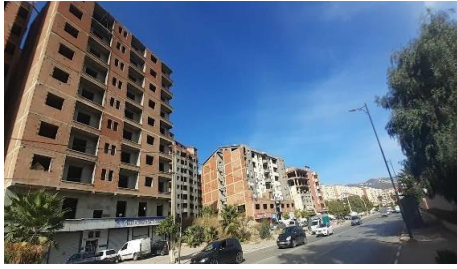
Figure 39 vue sur la rive nord de l'avenue Chabane Ahcene
