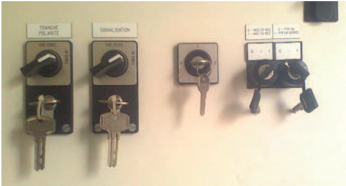
Figure 3 : Bouton de changement de différentes fonctions et regimes du SEPAM
