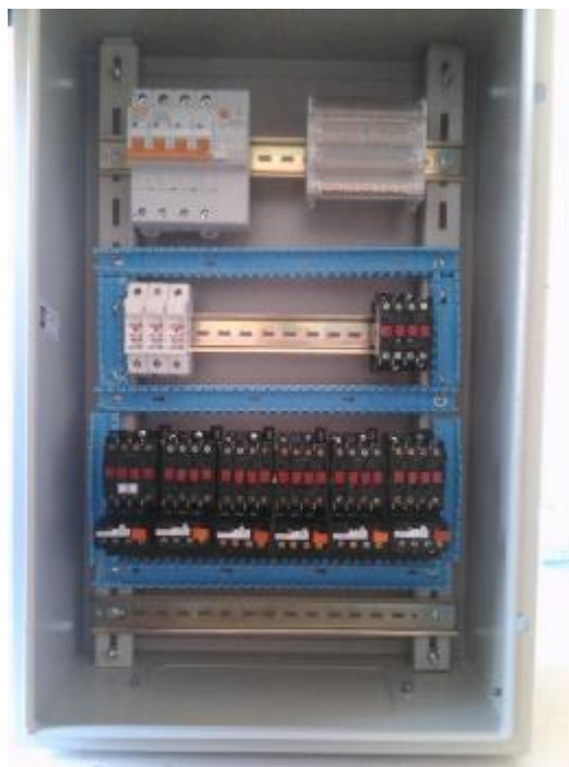
Figure 15 : Installation des goulottes et des appareils.
