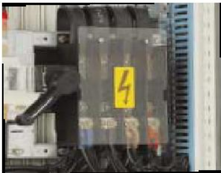
Fig.18 : Répartiteur 160/250 A [6]. Fig.19 : Répartiteur 250/400 A [6].
