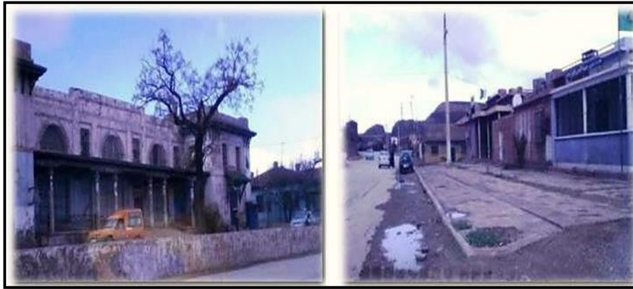
Fig.61 : dégradation du paysage et décoloration des constructions.
