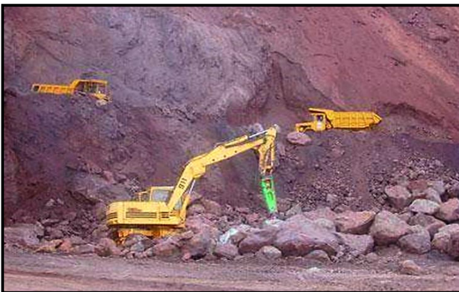
Fig.63 : Engins générateurs de bruit.
