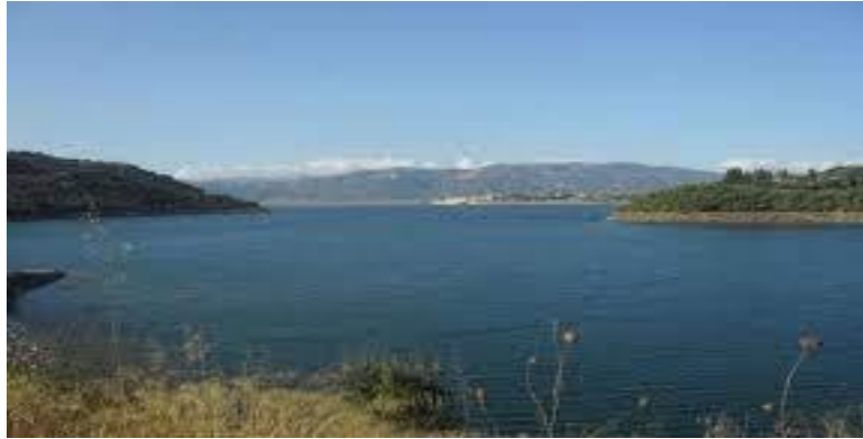
Figure I.1: Barrage de TAKSEBT
