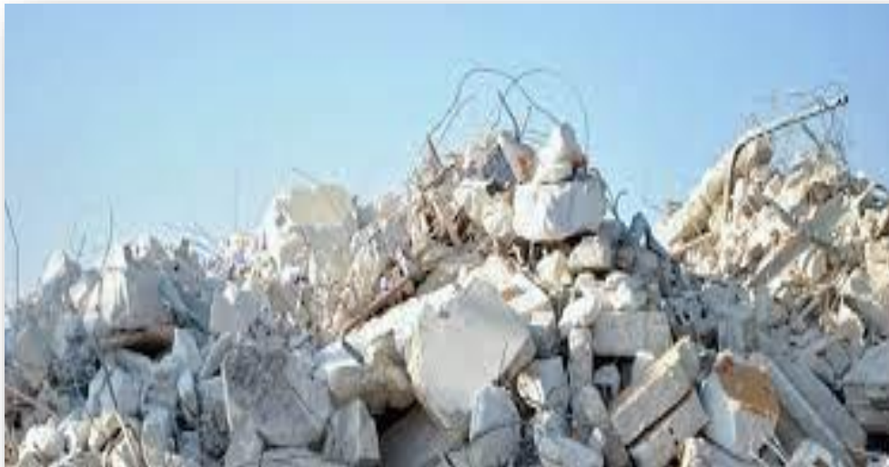
Figure I.A.11 : Déchets de démolition [5].
