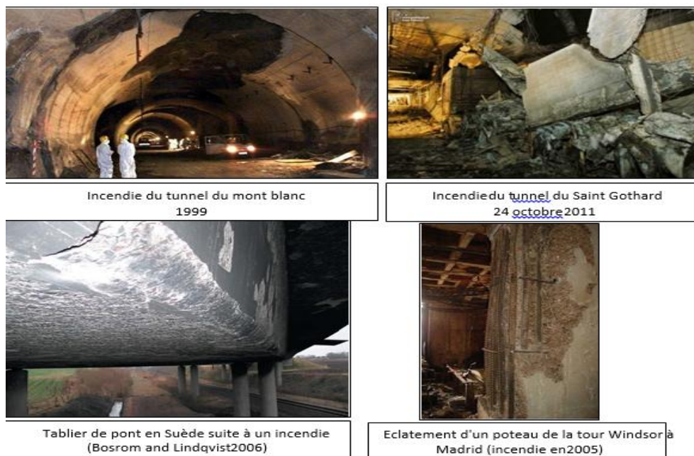
Figure I.B.1: Exemples des détériorations à la suite d'incendies.
