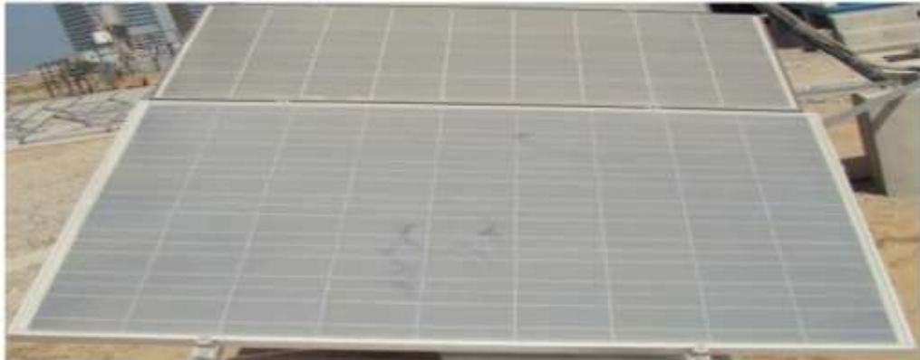
Figure II.6 : Accumulation de particule de sable sur un module [56].
