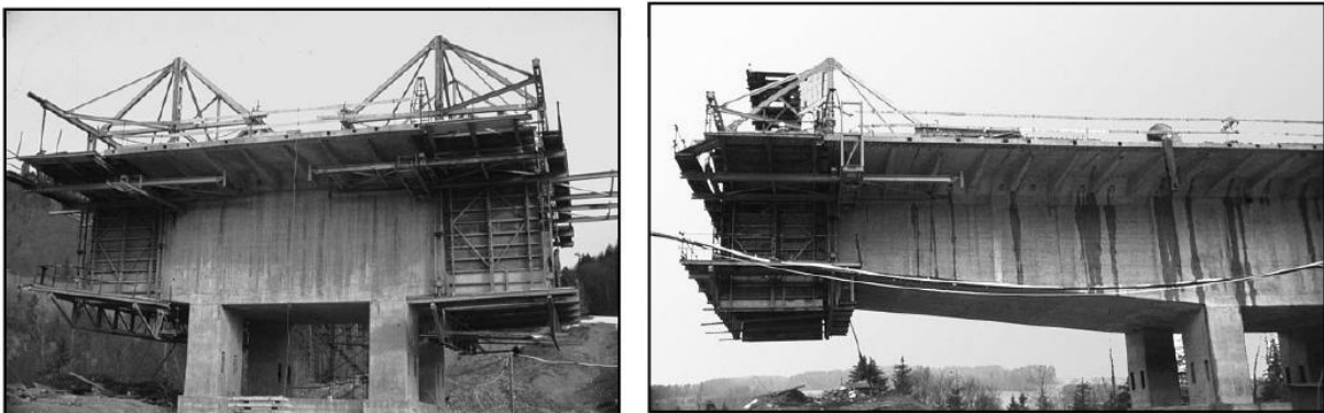
Fig. II.3 : Voussoirs coulés sur place.
