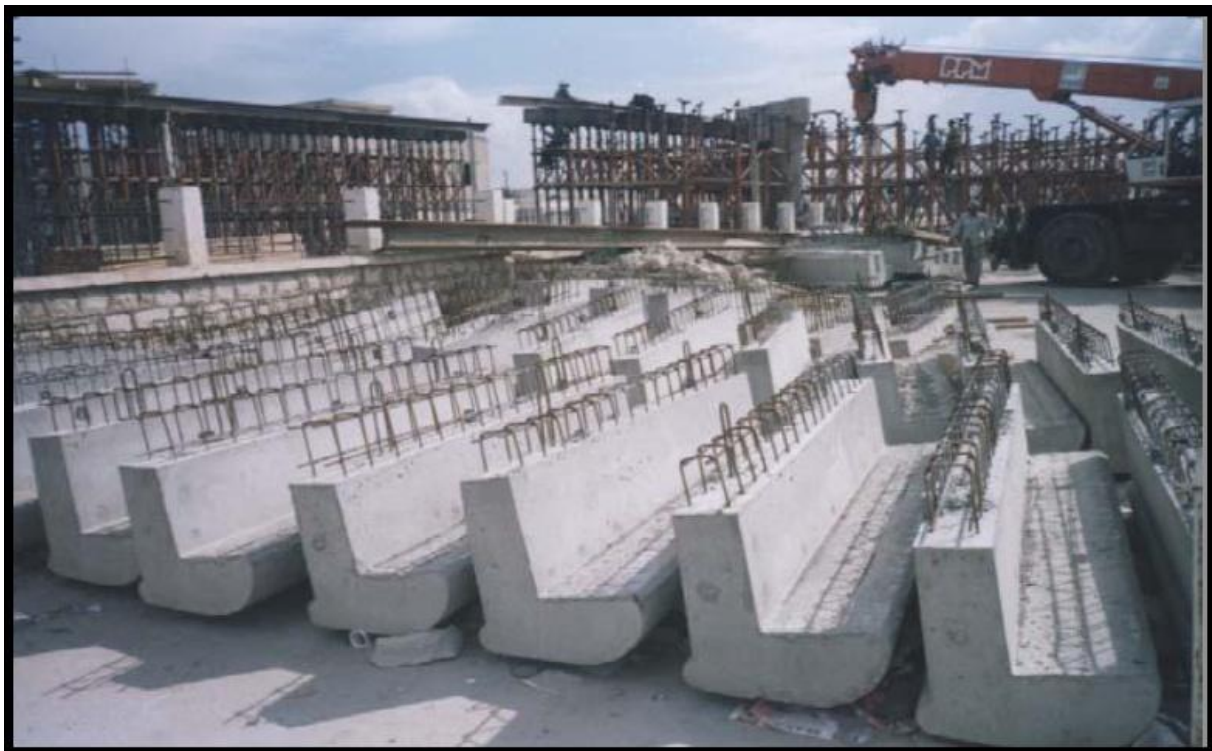
Figure X.14: Corniches préfabriquées sur chantier.
