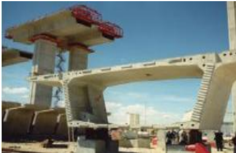
Fig. II.6 voussoir préfabriqué
