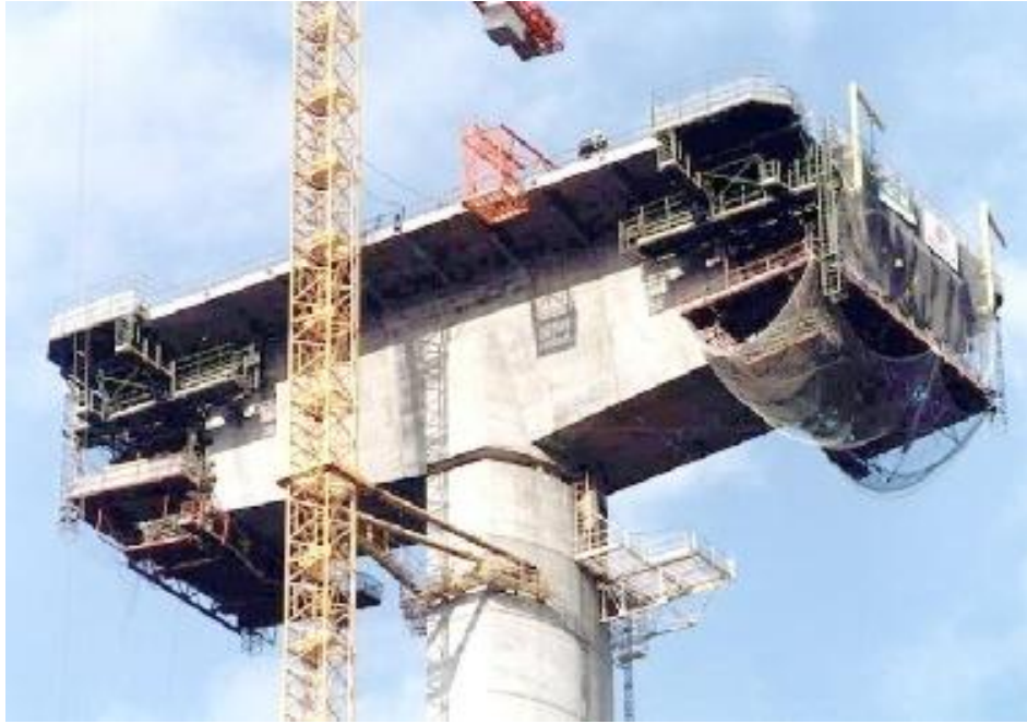
Fig. II.5 : deux équipages mobiles.
