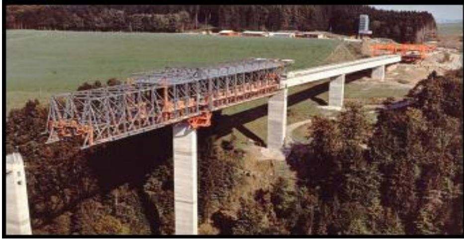
Fig. II.11 Construction par poussage
