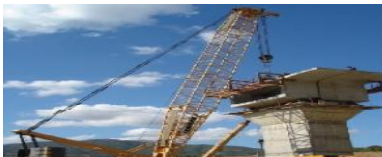
Fig. II.8 La pose des voussoirs par grue.
