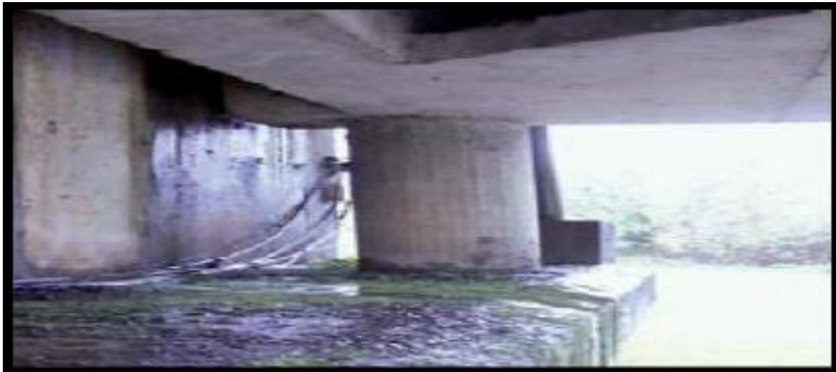
Fig. X.3. Appareils d'appuis en béton
