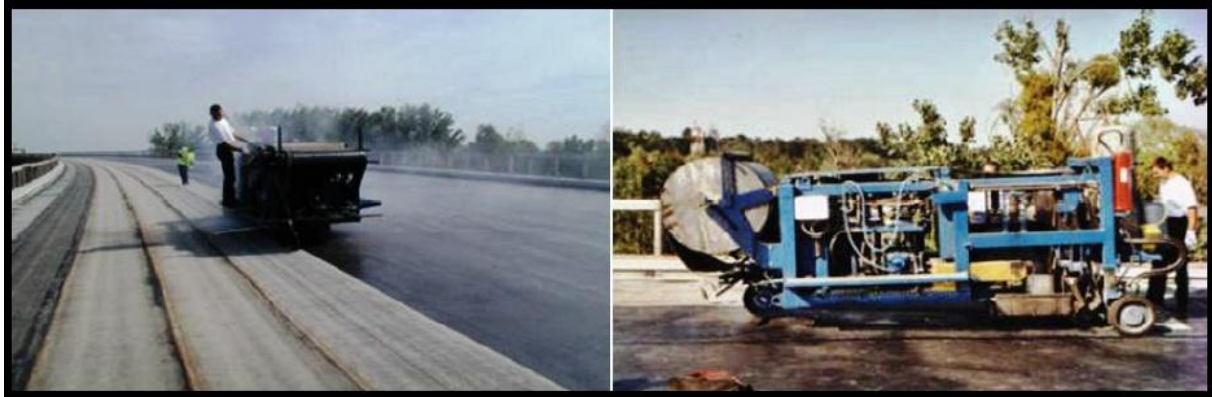
Figure X.13 : Revêtement du tablier.
