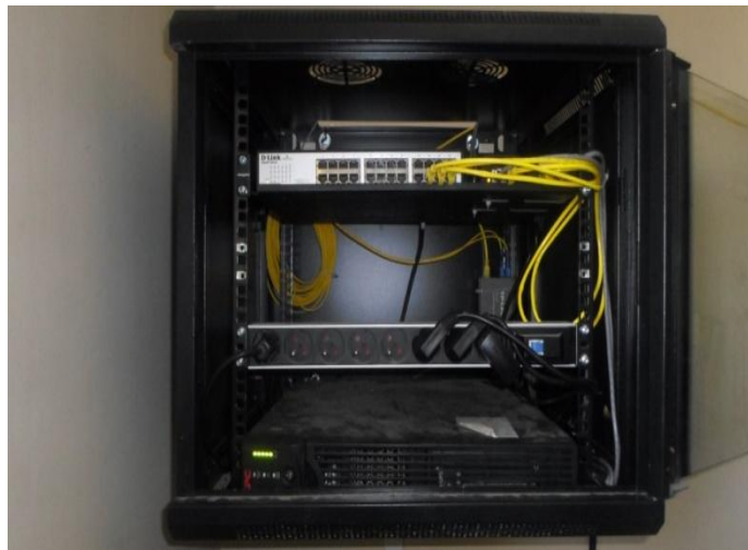
Figure 28 : l'armoire de brassage.
