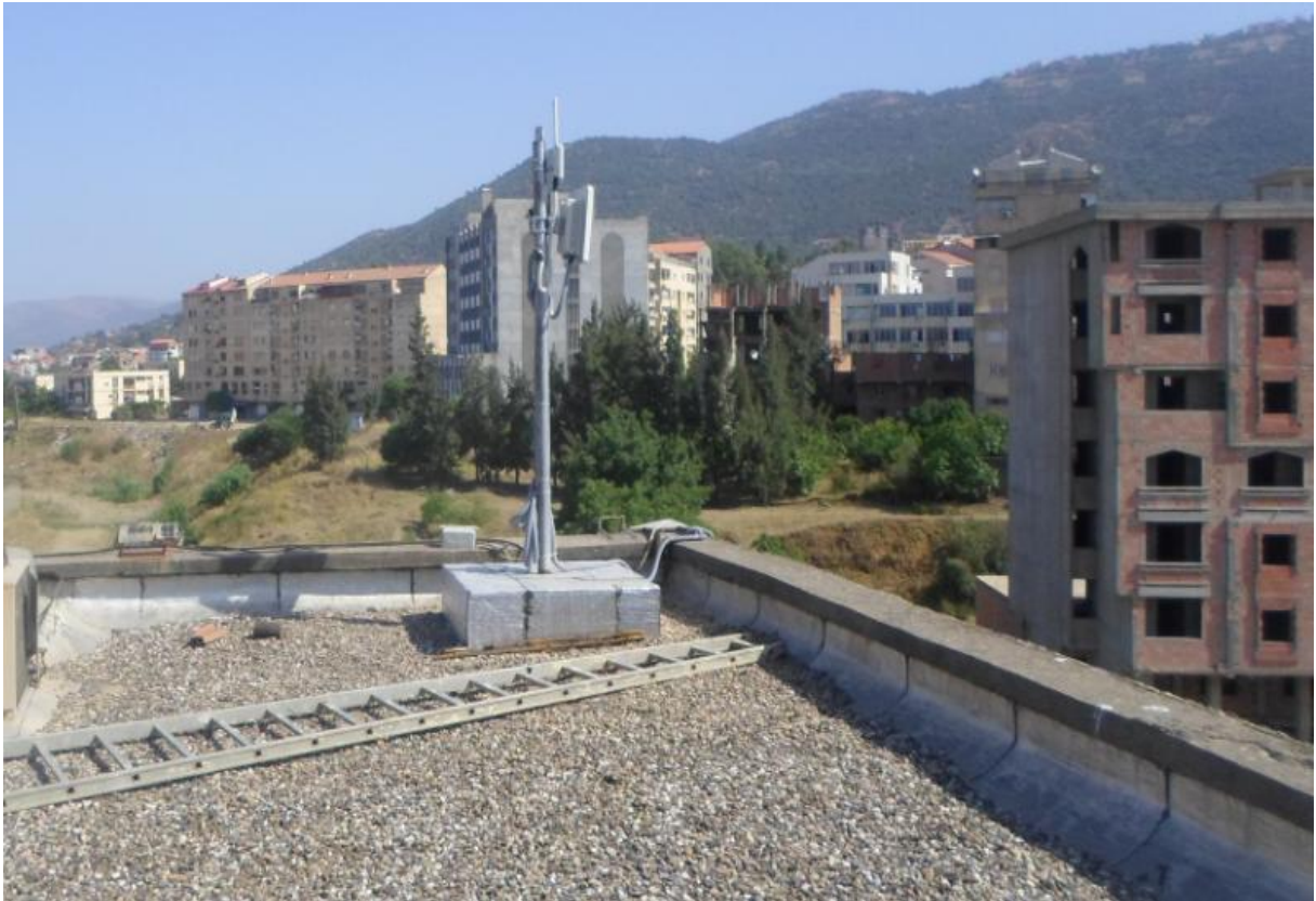
Figure 29 : Le AP est placé sur le toit de D.G.ENIEM
