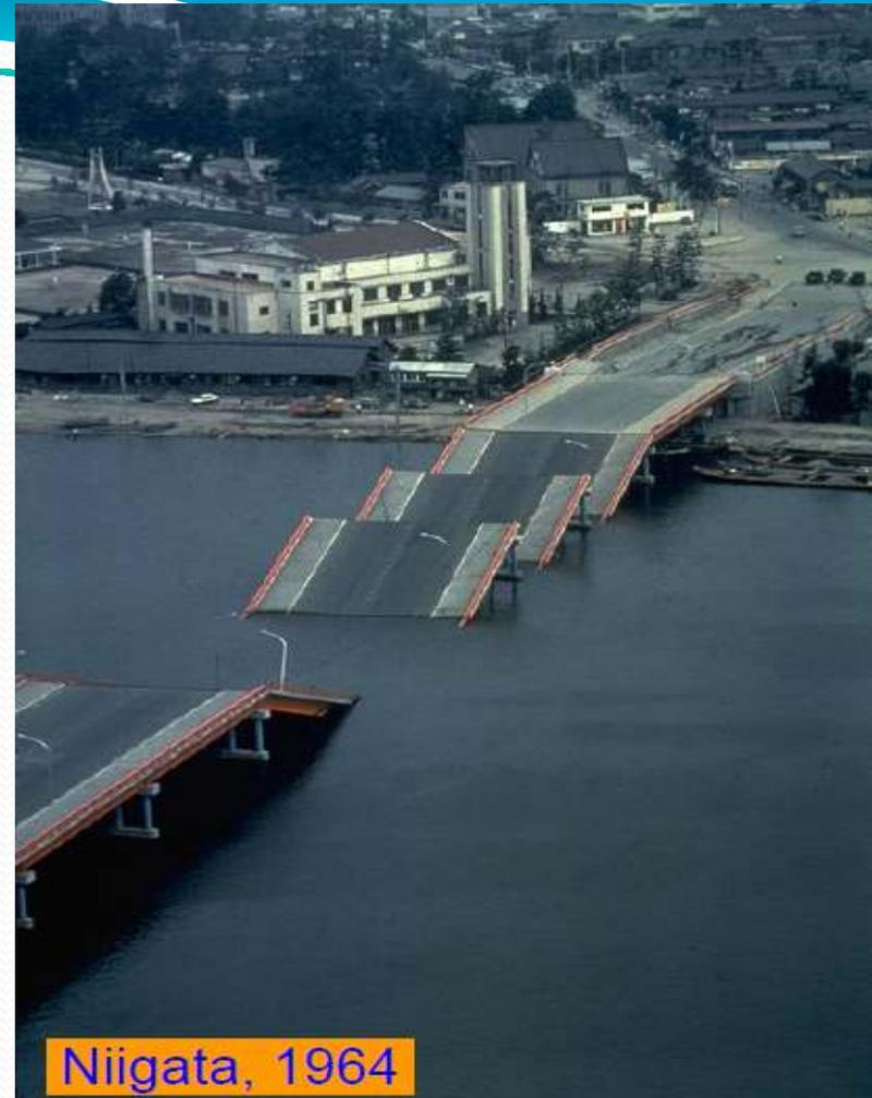
*Rupture de pont, due à l'épandage latéral dans le sol*
