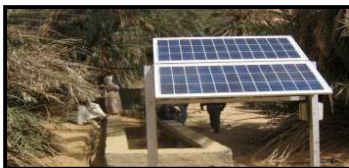
Figure 32: Image d'une pompe solaire
