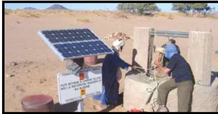
Figure 17 : Image représentative d'une installation d'une pompe solaire
