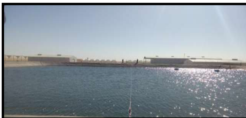
Figure24 : Photo d'un bassin de 10 000 m 3
