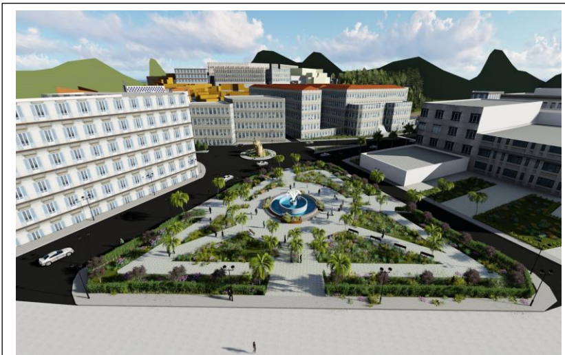
Figure 39: Vue sur la place Ounouri Source : l'auteur
