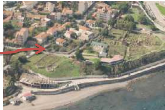
Figure22 : Vue sur le périmètre d'étude Source : Google Earth
