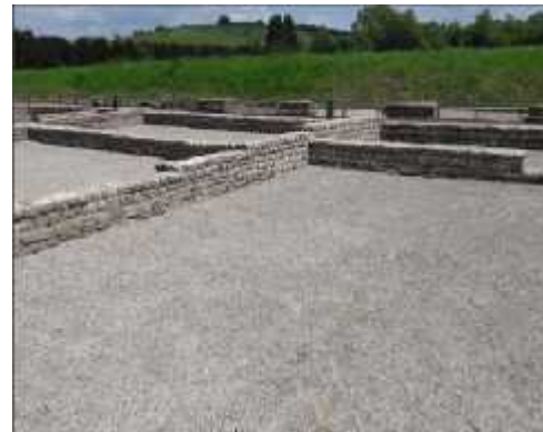
Figure107 : Vue des vestiges des bâtiments rectangulaires
