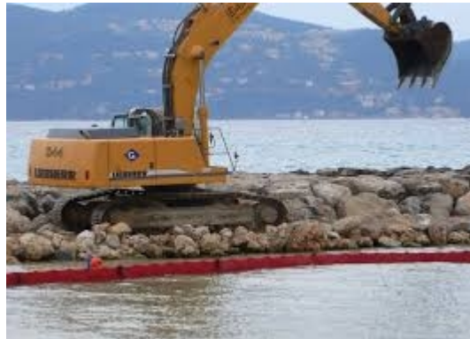
Figure 6 : Exemple des travaux en site maritimes[1]
