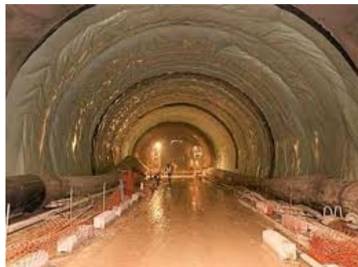
Figure5 : Exemple des travaux souterrains[1]
