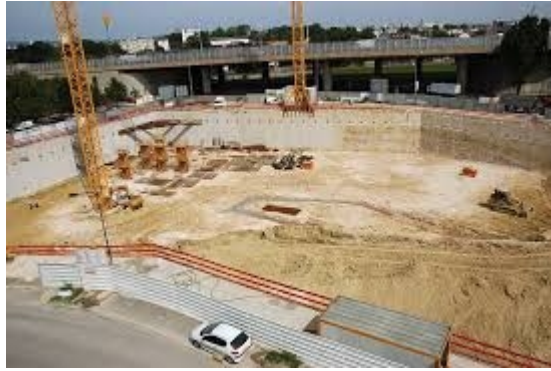
Figure3 : Exemple des travaux de terrassement[1]
