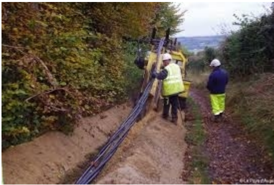
Figure 23 : Implantation d'un réseau électrique [1]
