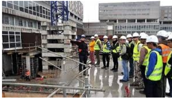
Figure 1: Exemple d'un chantier bâtiment [1]
