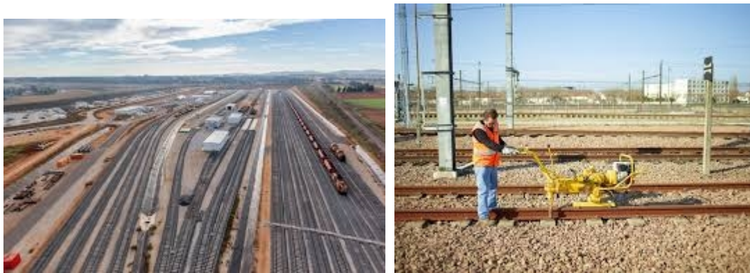
Figure 7 : Exemples des travaux des voies ferrés [1]
