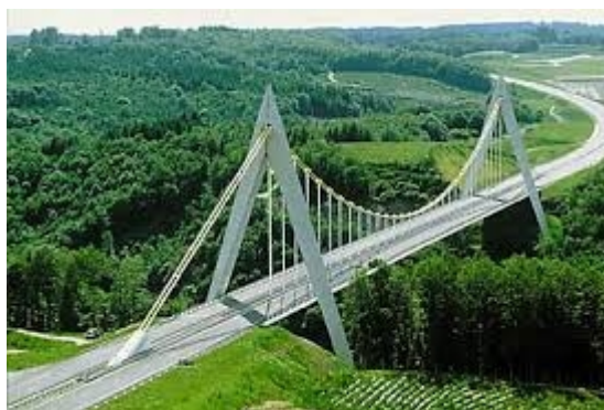
Figure 2 : Exemple d'ouvrage d'art[1]
