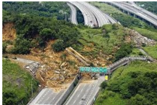
Figure 9 : Glissement de terrain[1]
