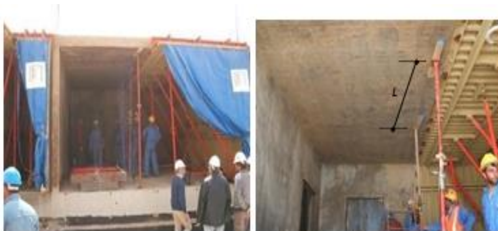
Figure IV.23 : installations des étaitements
