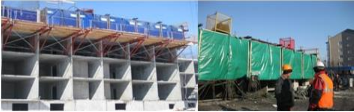
Figure IV.20 : Installation du matériel des chauffages
