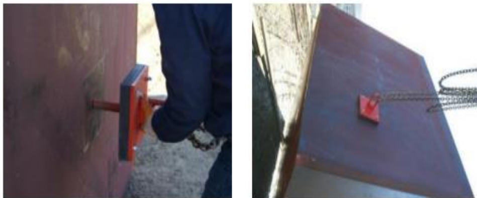
Figure IV.9 : détail de montage de l'écrou de levage
