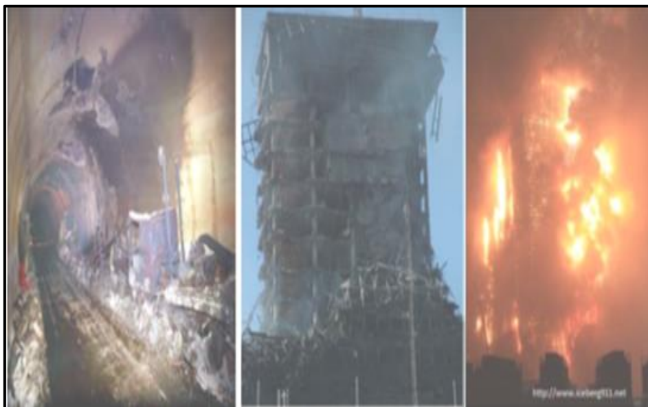
Figure II.3 : Dégradation d'ouvrages en béton suite à un incendie [ 21].
