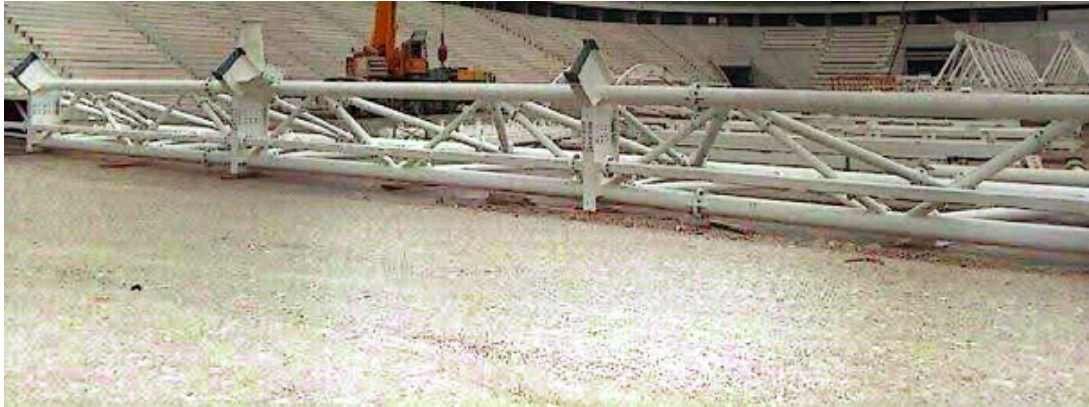
FIGURE 5.3 – Préassemblage d'une partie de l'arc avec le treillis.
