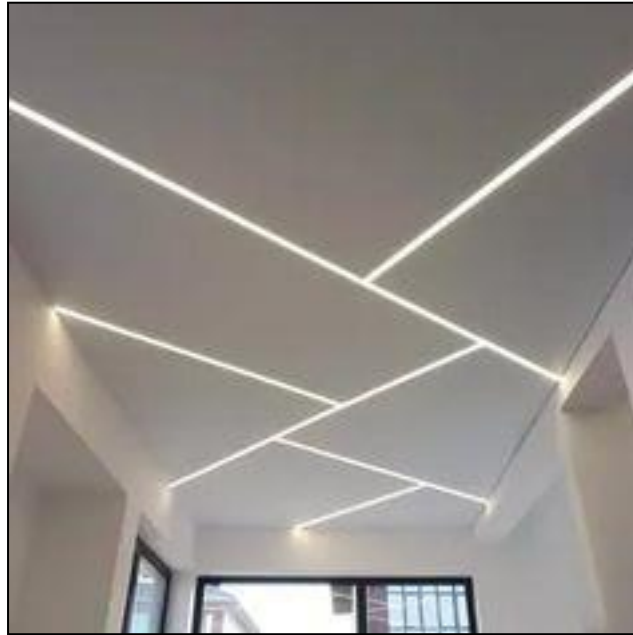
Figure 74 : faux plafond placo plâtre Source : https://i.pinimg.com/
