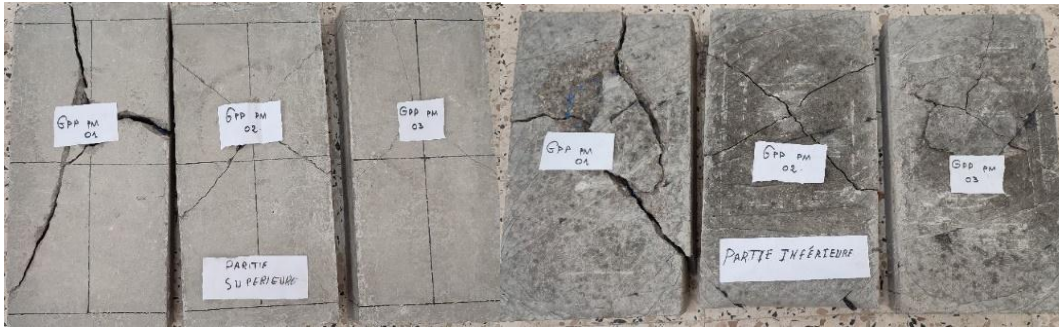
La figure V.21 Vue de mode de rupture sur les parties supérieures et inférieures des dalles renforcées avec des fibres en polypropylènes de petites mailles (GPP/PM)
