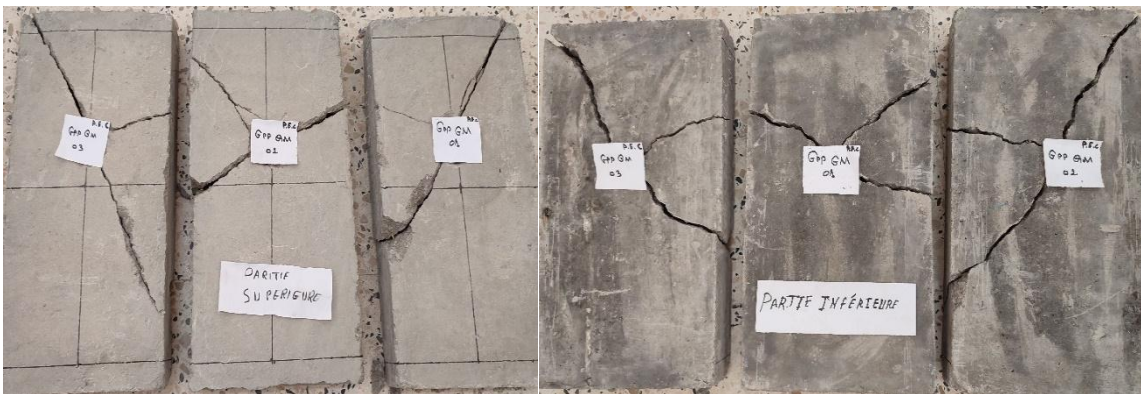
La figure V.22 Vue de mode de rupture sur les parties supérieures et inférieures des dalles renforcées avec des fibres en polypropylènes de petites mailles (GPP/GM) .
